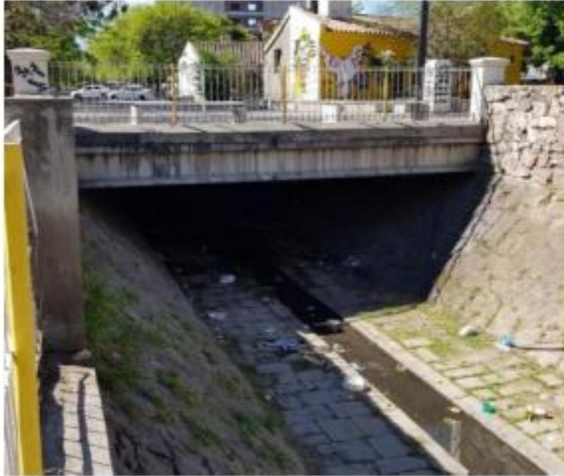
Imagen 3: Canal Alvear sección trapecial a cielo abierto
