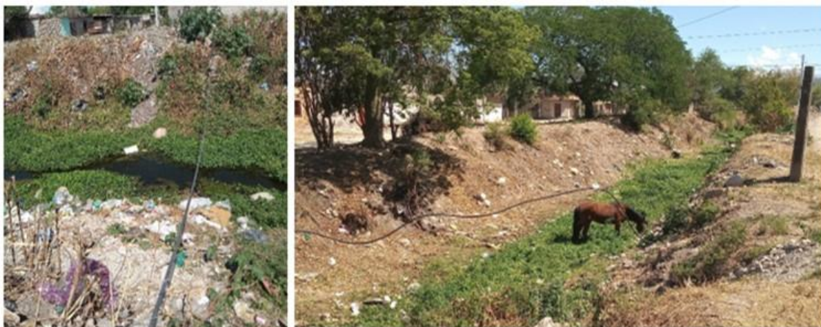
Figura 1.1 A Estado actual, Canal Alvarado
