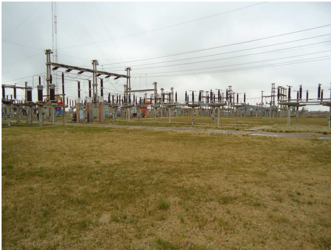
Fotografía 2.3-1: S.E.T. Rufino, dentro del predio de la Estación Transformadora se harán las ampliaciones correspondientes a los campos de entrada y salida de la nueva línea de 132 kV Charlone-Rufino.
