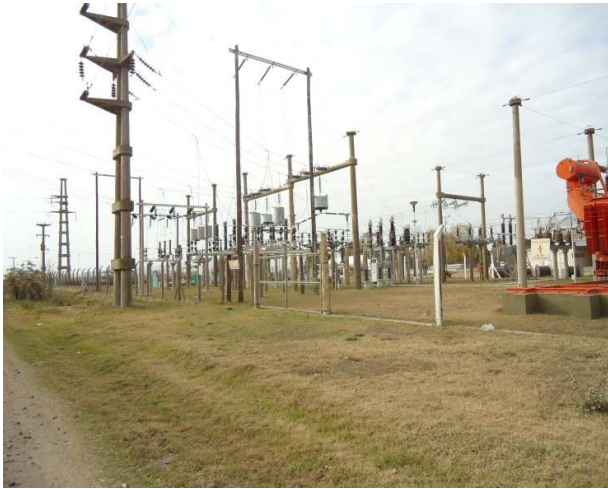
Fotografía 2.3-1: E.T. Laboulaye, dentro del predio de la Estación Transformadora se harán las ampliaciones correspondientes a los campos de entrada y salida de la nueva línea de 132 kV Charlone-Laboulaye.
