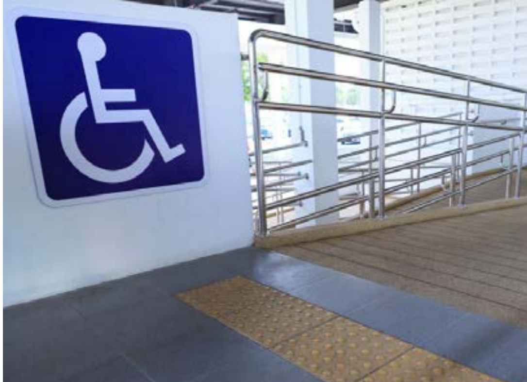
Fotografía de una rampa con señales podotáctiles y el símbolo de discapacidad.
