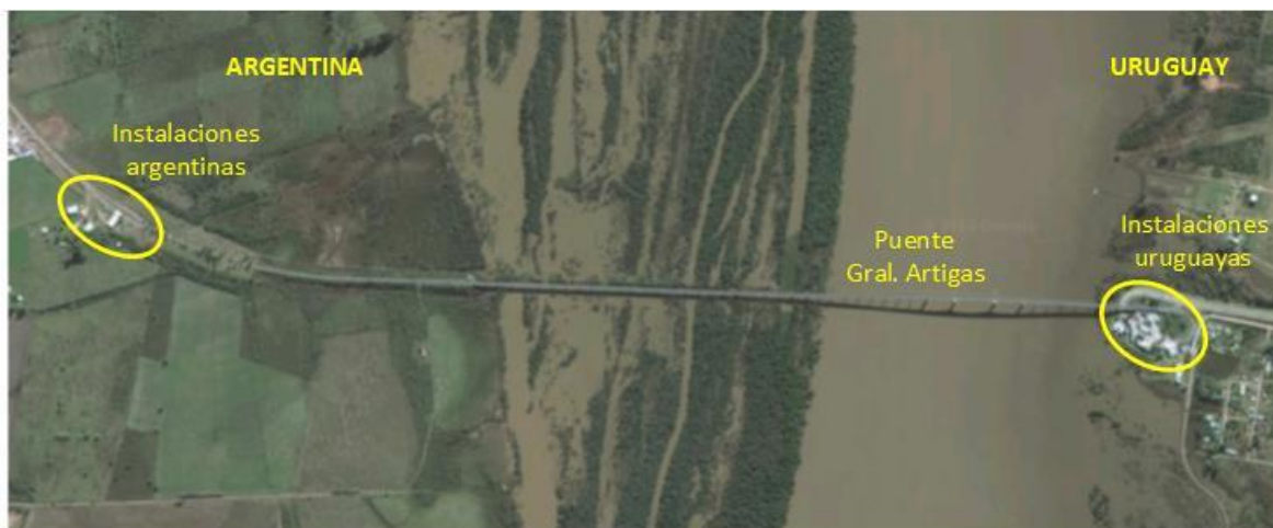
Imagen 1 – 3. Detalle general de las instalaciones del paso
