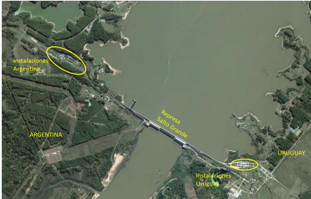
Imagen 1-4 Detalle general de las instalaciones del paso
