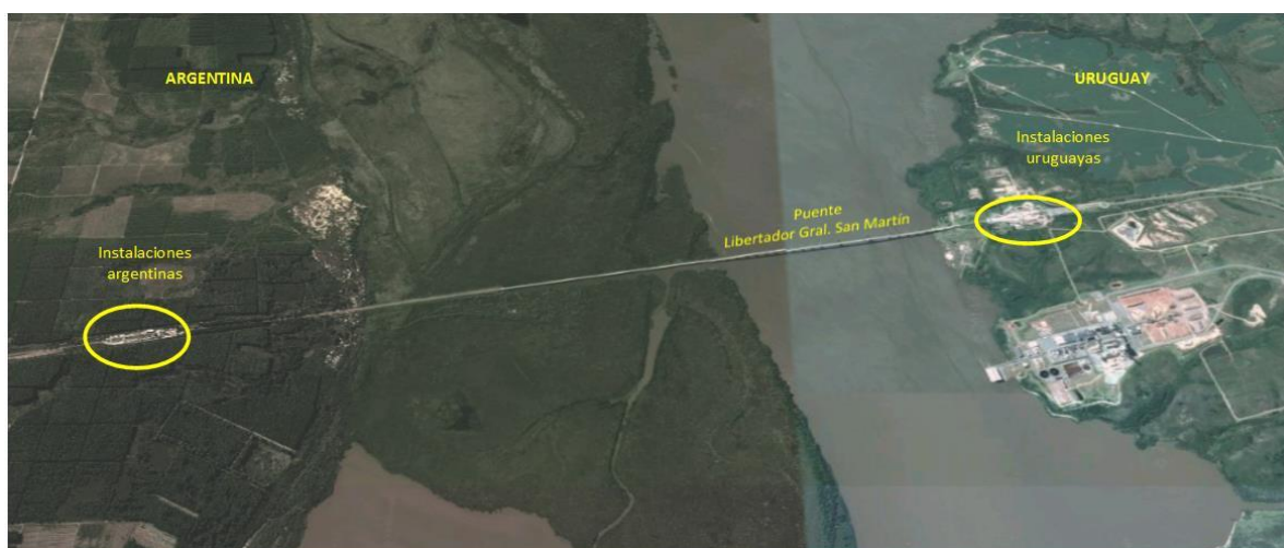
Imagen 1 – 2. Detalle General de las Instalaciones del Paso
