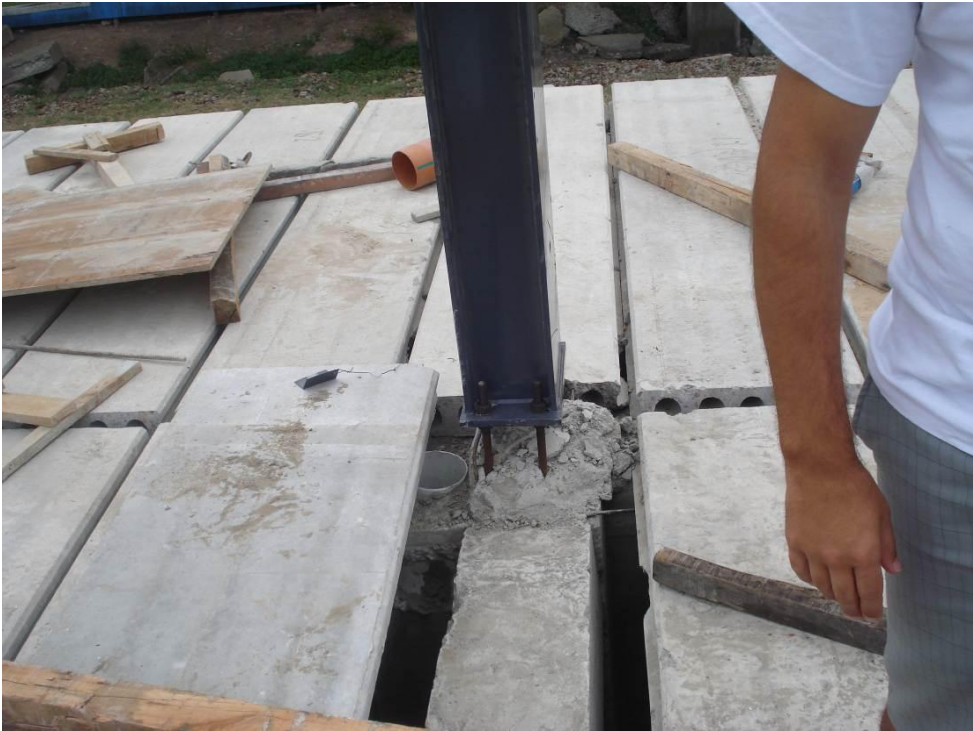
Figura 11: Ajuste de Losetas
