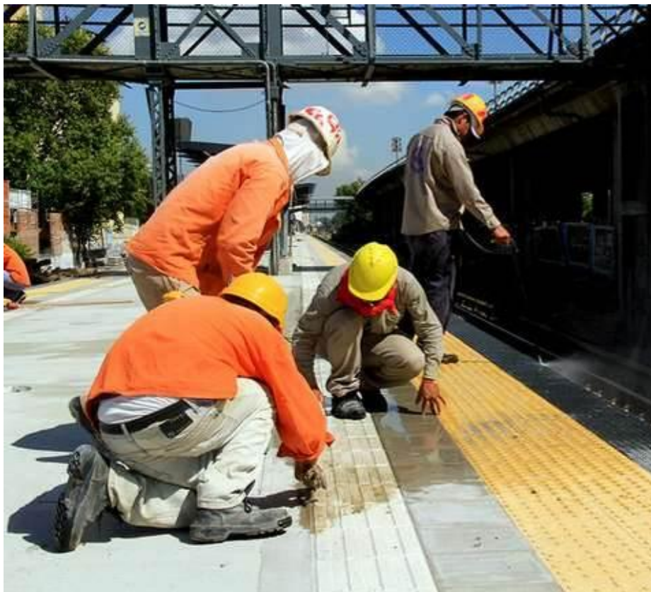
Figura 16: Colocación de pisos reglamentarios
