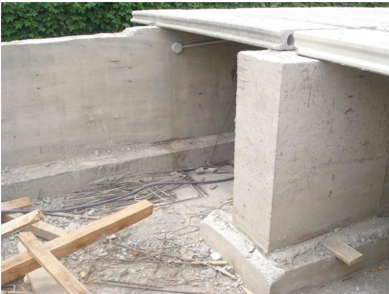
Figura 14: Andén con Zapata Intermedia
