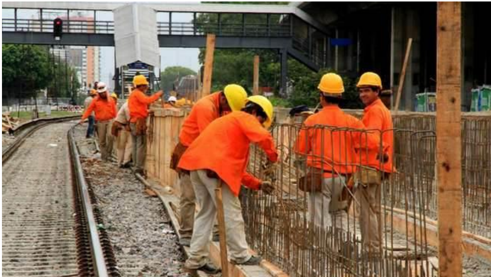
Figura 8: Armado de las Zapatas
