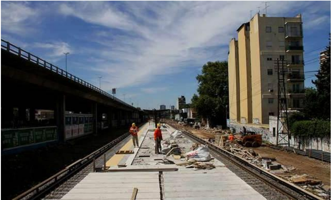
Figura 12: Colocación de las Losetas
