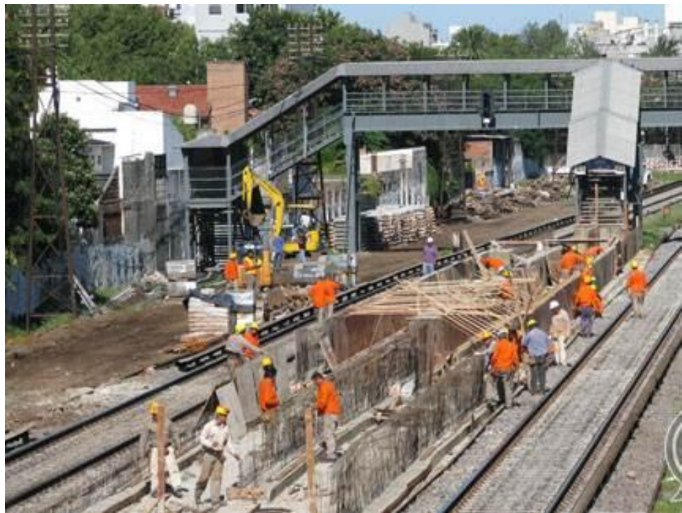
Figura 9: Armado de las Zapatas
