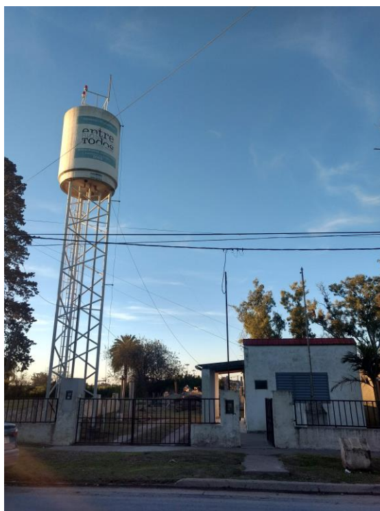
Tanque de Agua
