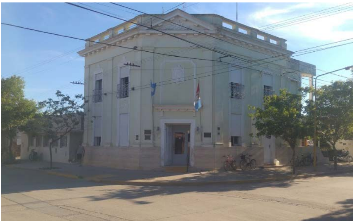
Edificio principal de la Municipalidad.
