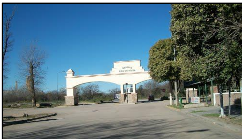
Nodo centro intersección de R.N N°9.
