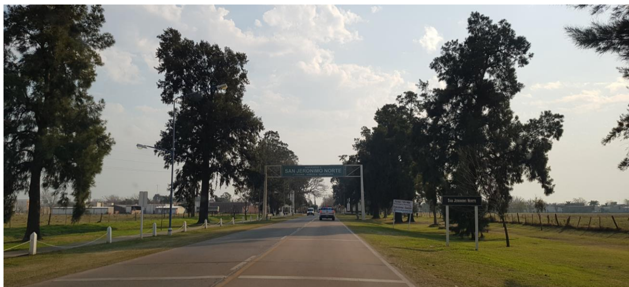
Ingreso principal a San Jerónimo Norte – Fuente: Consultor por SPTYCOP
