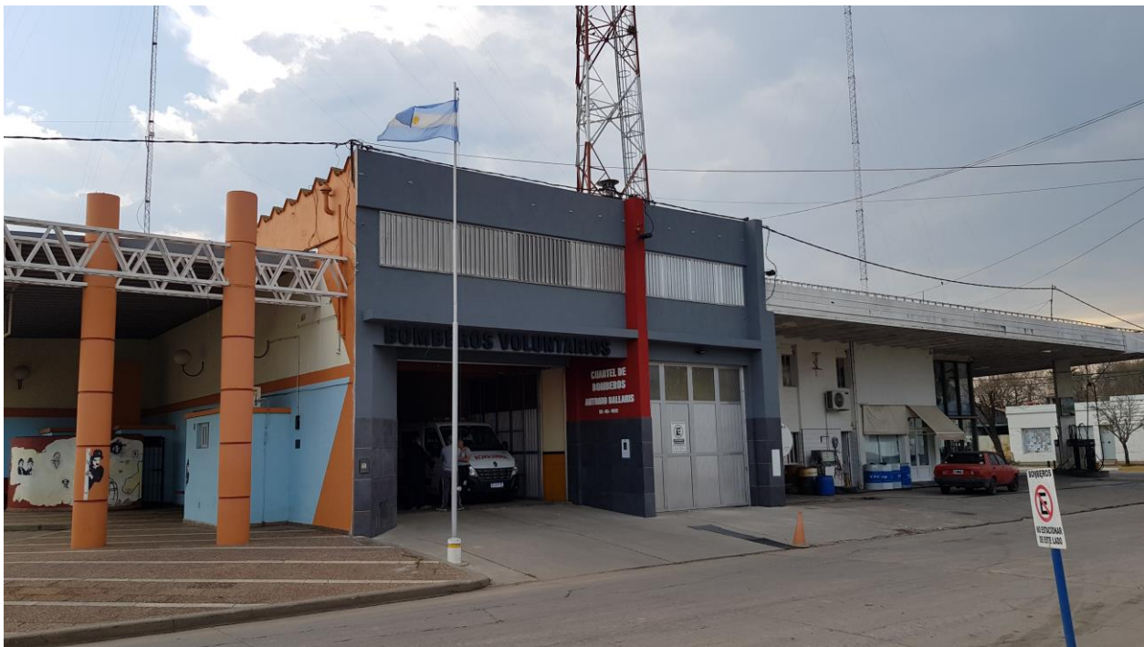
Cuartel de bomberos – Fuente: consultor por SSPTIP
