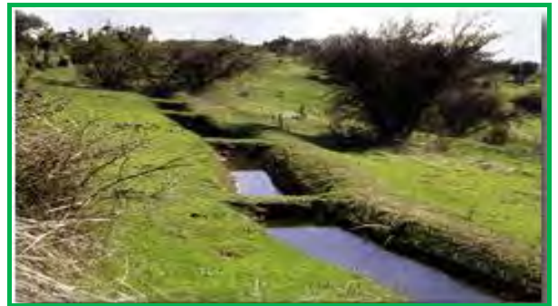
Ejemplo: Sistema de drenaje lateral
