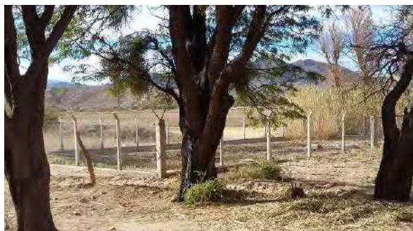
Planta de tratamiento de líquidos cloacales
