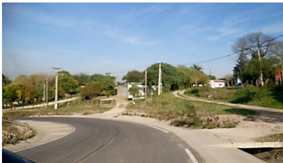
ACCESO Y CALLES SECUNDARIAS
