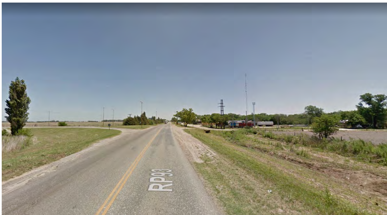
Acceso de ingreso desde RP N° 93
