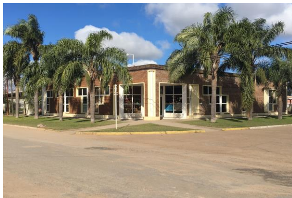
EDIFICIO MUNICIPAL FUENTE: Relevamiento propio 07/06/2018
