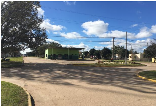
TERMINAL DE OMNIBUS FUENTE: Relevamiento propio 07/06/2018
