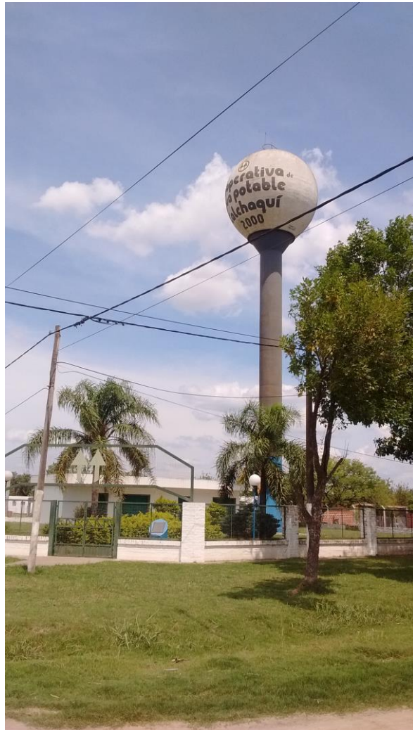
Tanque de provisión Agua Potable Cooperativa en zona urbana. FUENTE: Elaboración propia
