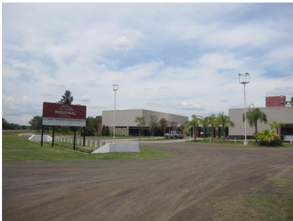
Hotel Regional, sobre Ruta 11 Fuente: Elaboración propia
