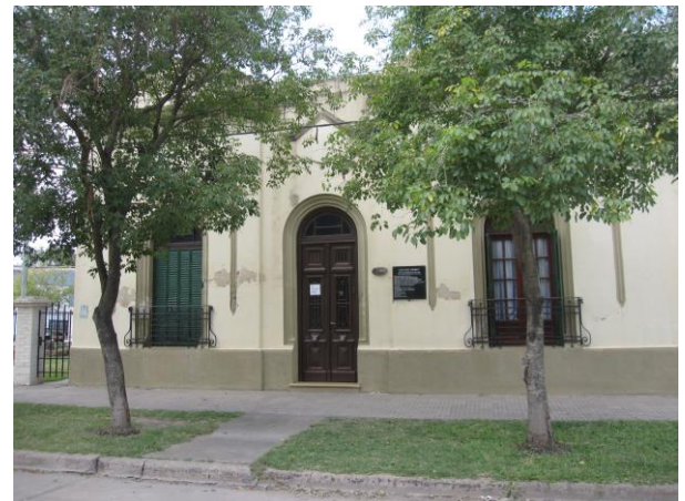
Edificio Concejo Municipal – Valor patrimonial
