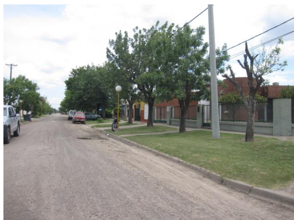
Calles de ripio con cordón cuneta en zona urbana
