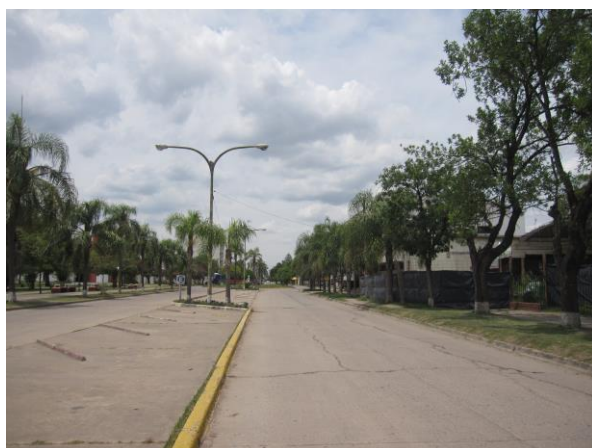
Columna Alumbrado doble sobre Boulevard Belgrano
