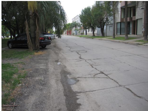
Estado general de calles pavimentadas
