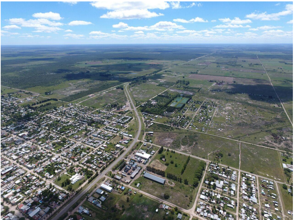
Foto aérea localidad de Calchaquí desde el sudeste, se destaca la traza de la RN 11 / Piletas tratamiento / Basural a cielo abierto y asentamientos FUENTE: Archivo Municipalidad Calchaquí
