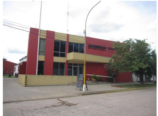
Edificio Sede Bomberos Voluntarios FUENTE: Elaboración propia
