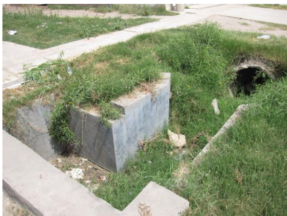
Zanjas desagües y cruce con entubamiento del Canal Santa Rosa
