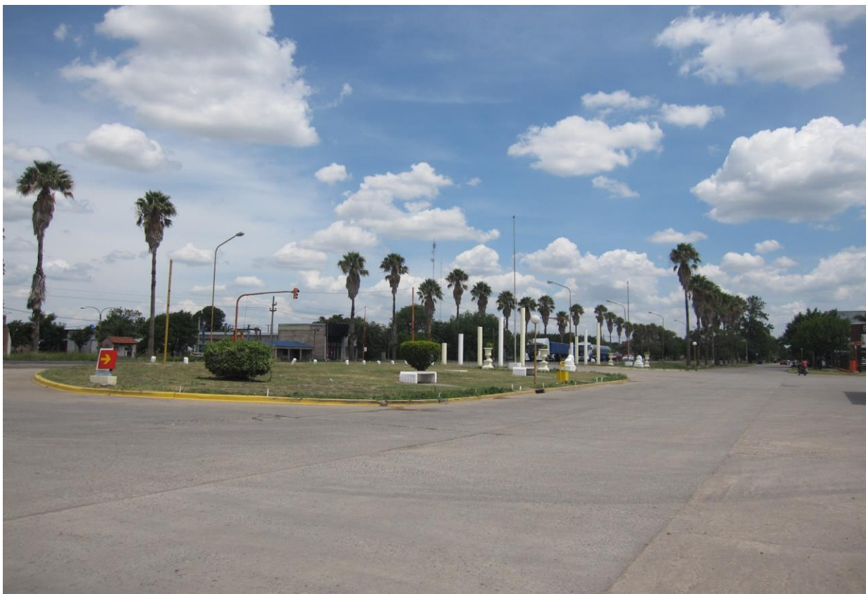
Ingreso a Calchaquí desde la ruta Nacional. FUENTE: Elaboración propia
