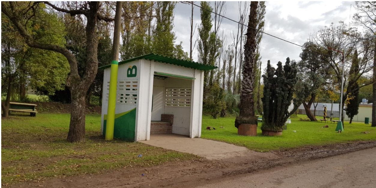
Garita sobre Avenida Centenario. Fuente: Consultor por SPTYCOP.
