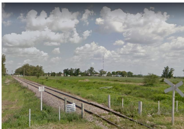
Red Ferroviaria en su cruce con Ruta 39
