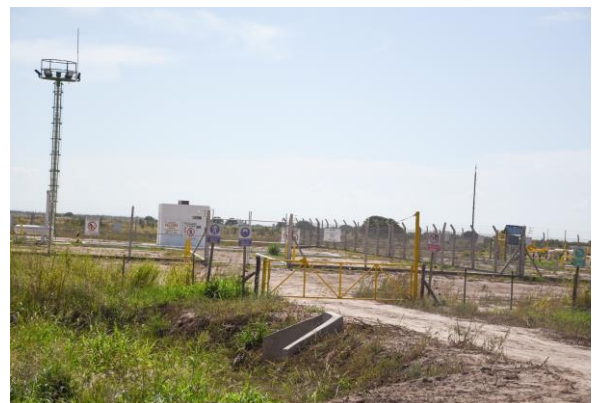
Puesto de control de Litoral Gas en la zona noroeste FUENTE: Lucía Femenia - Fotografía
