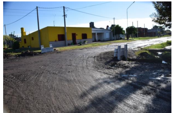
Calles de tierra en zona urbana sur
