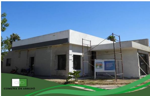
COMISARIA 7MA ARRUFÓ EN REFACCIÓN FUENTE: Archivo comuna Arrufó
