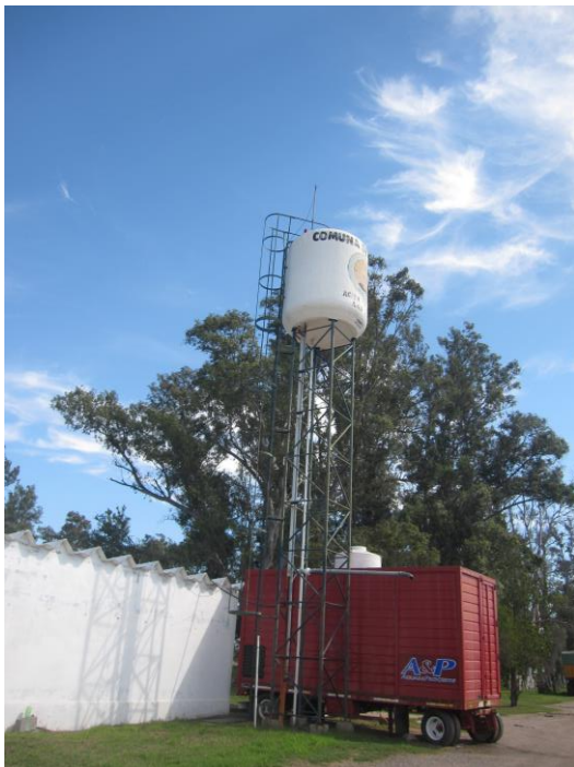
Tanque de agua potable para provisión FUENTE: Elaboración Propia
