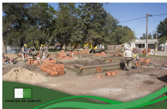
Loteo y 12 viviendas Avance de obra Mayo 2018 FUENTE: Archivo comunal
