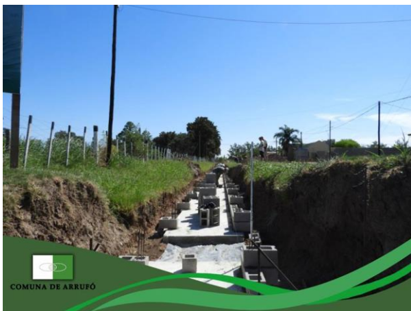
SANEAMIENTO Y DESAGUE CALLE JAVIER ARRUFÓ FUENTE: ARCHIVO COMUNAL
