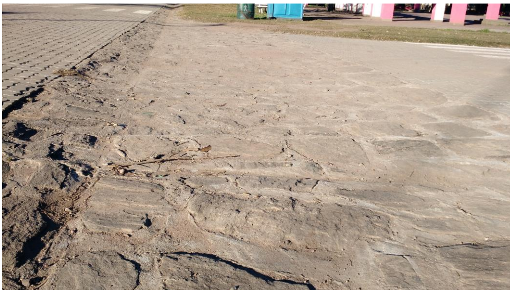
Fuente: Pavimentación con adoquines de piedra en la Municipalidad de San Pedro Norte
