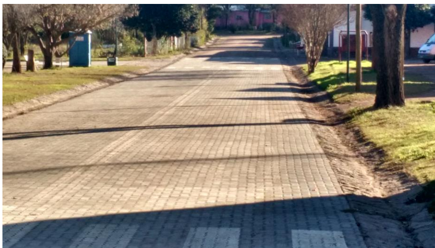
Fuente: Municipalidad de San Pedro Norte. Cordón cuneta tipo serrano y pavimentación con adoquines intertrabado.
