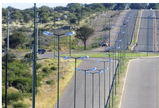
Ensanche Ruta Prov.N°14 con rotondas de acceso, cantero central con iluminación Led. Foto ilustrativa
