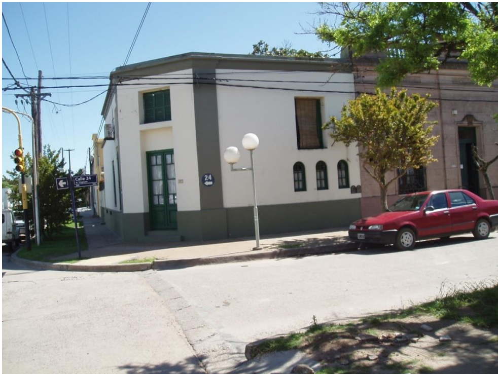
Casa en casco urbano sobre calle 24 en Navarro
