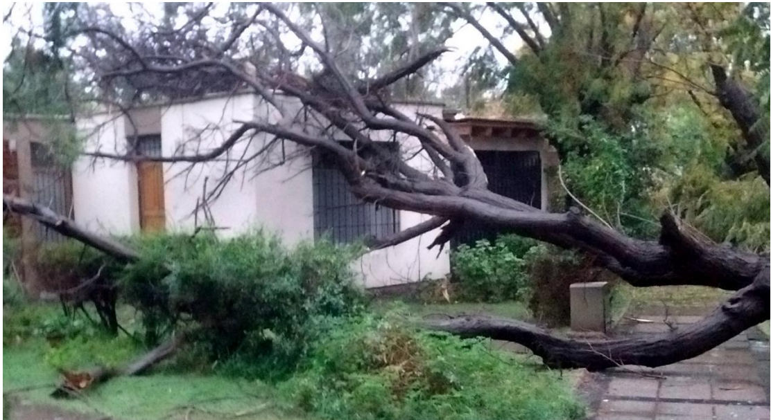
Figura 4: Caída de árboles en el AMM. Fuente: Diario digital El Sol ( https://www.elsol.com.ar/nota/301698 )
