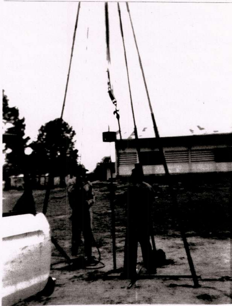
GEOFOTO N° 1: VISTA DE TÉCNICOS ENCARGADOS DEL ESTUDIO DEL SUBSUELO EN EL LUGAR MEDIANTE EL MÉTODO DE TERZAGHI: EQUIPOS Y MOVILIDAD UTILIZADOS AL EFECTO.-
