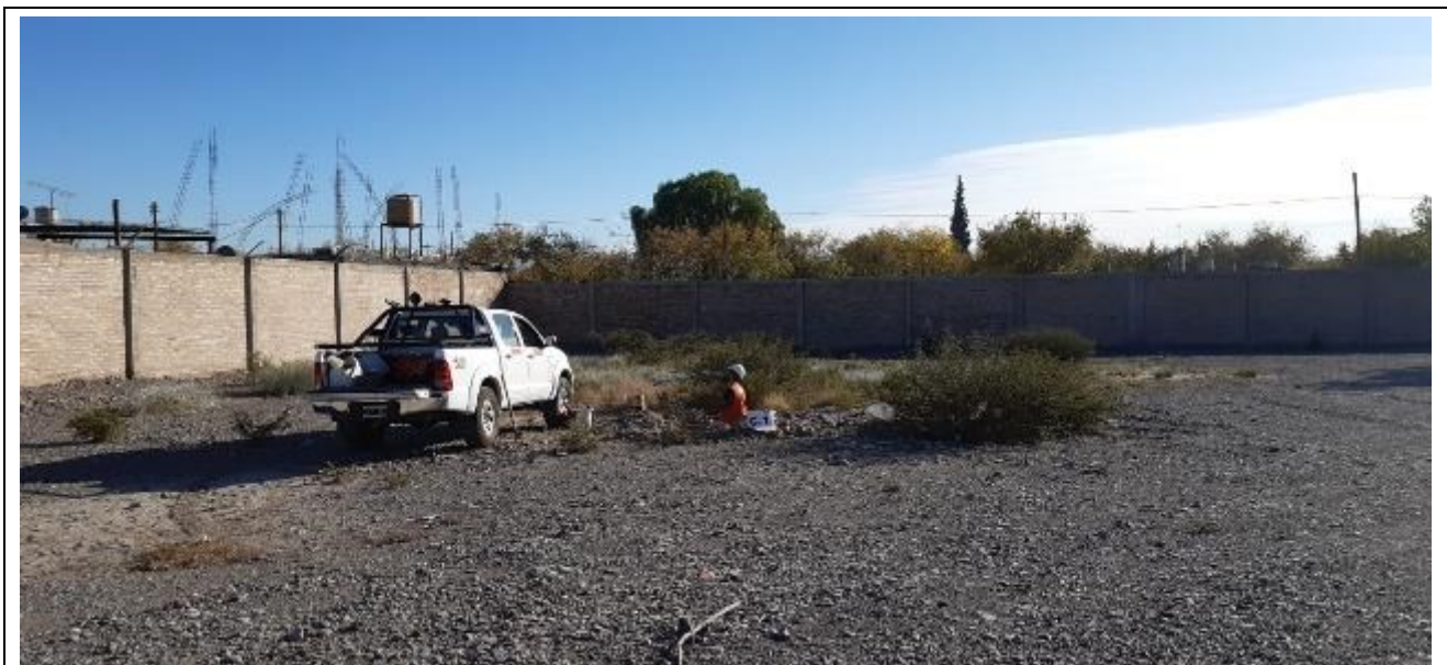
Fotografía N°6: Calicata C.1. Se muestra la posición de la calicata ejecutada en el terreno estudiado, se observan los trabajos de excavación y toma de muestra.
