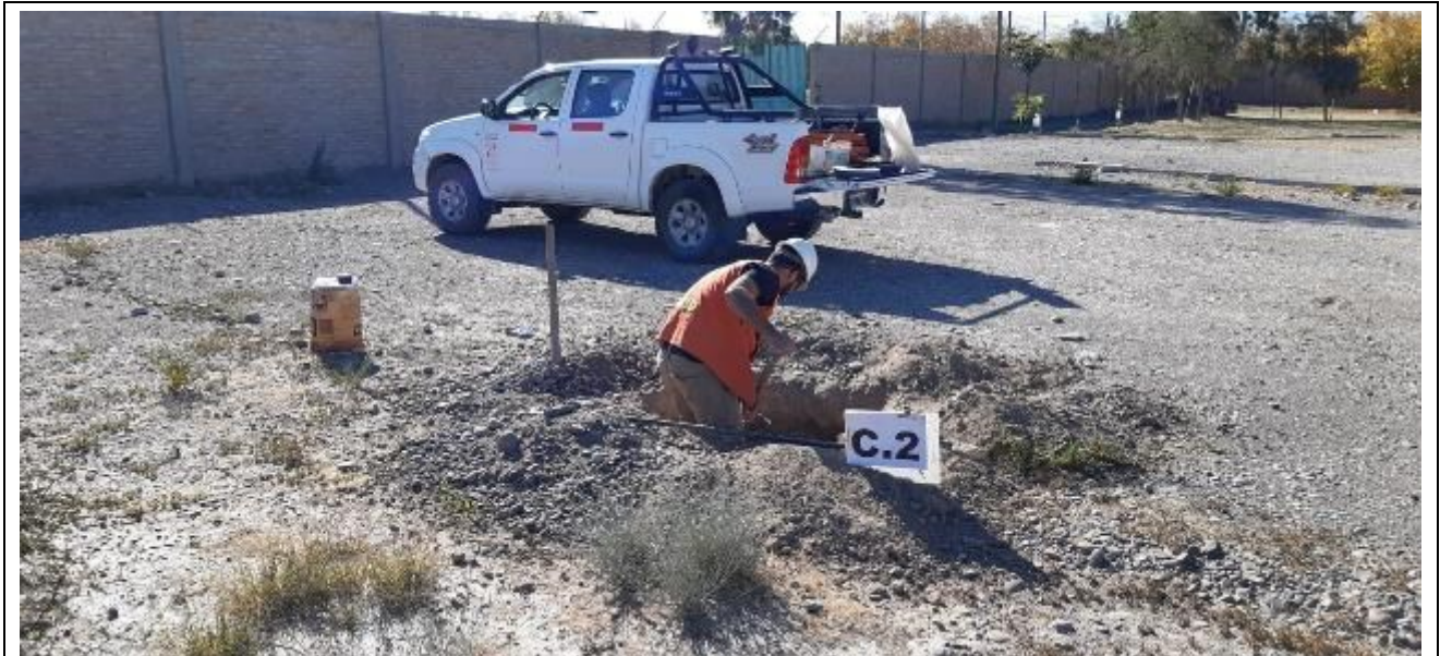
Fotografía N°13: Calicata C.2 . Se muestra la posición de la calicata ejecutada en el terreno estudiado, se observan los trabajos de excavación y toma de muestra.
