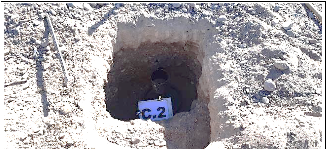
Fotografía N°14: Se muestra la excavación de la calicata C.2 , observando el perfil estratigráfico de suelos formado por un estrato superior de suelo natural compuesto por un limo arenoso con gravas de 0,25m de espesor, y subyacente le continúa un segundo estrato de suelo natural formado por gravas arenosas. Se observa el ensayo de densidad in situ por el método del cono y la arena (Norma DNV) a la Prof. de 1,00m en el estrato subyacente de grava arenosas.
