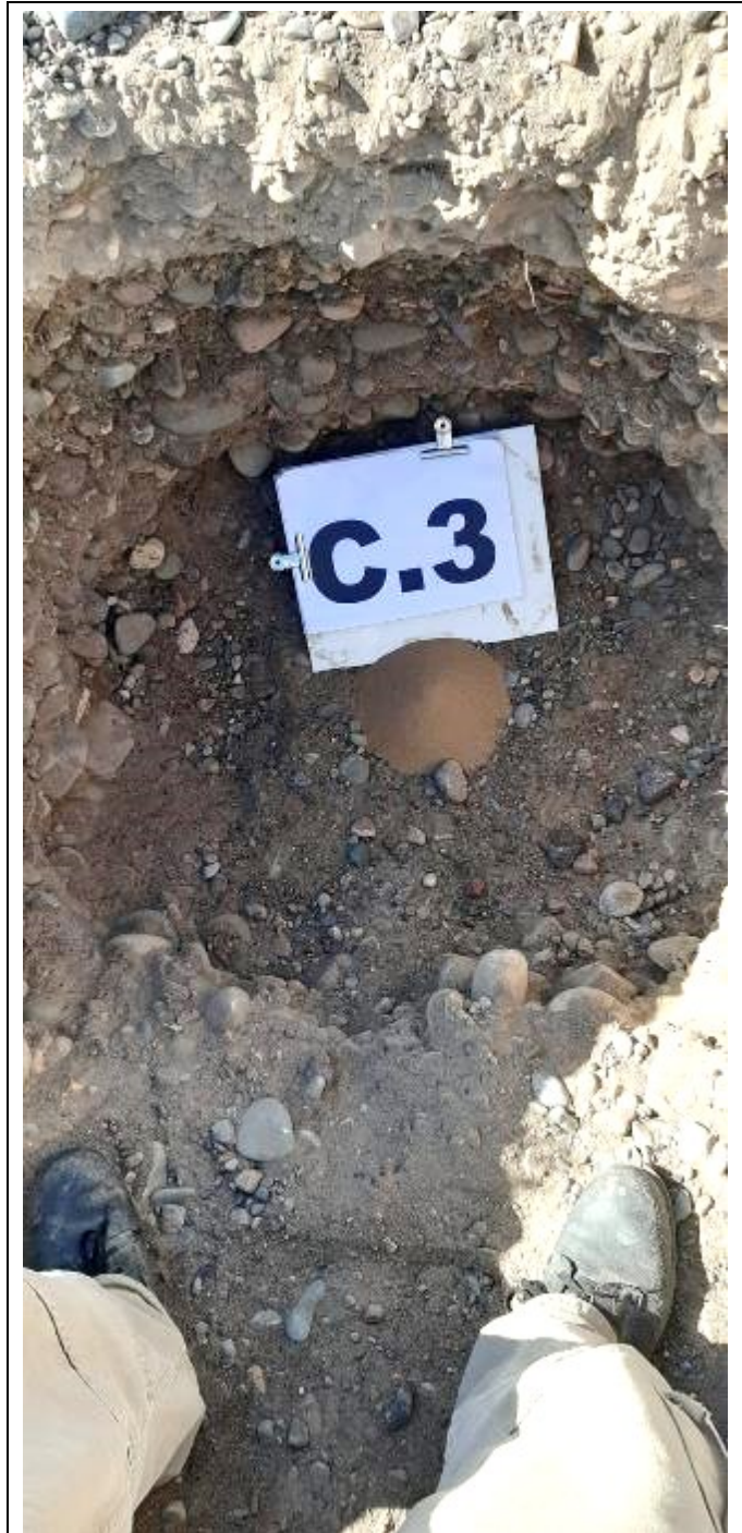
Fotografía N°18: Se muestra la excavación de la calicata C.3 , observando el perfil estratigráfico de suelos compuesto formado por un relleno superior de 0,20m, le continúa el estrato de suelo natural granular grueso formado por gravas arenosas.
