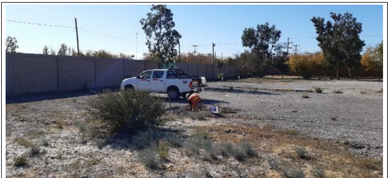
Fotografía N°12: Calicata C.2. Se muestra la posición de la calicata ejecutada en el terreno estudiado, se observan los trabajos de excavación y toma de muestra.
