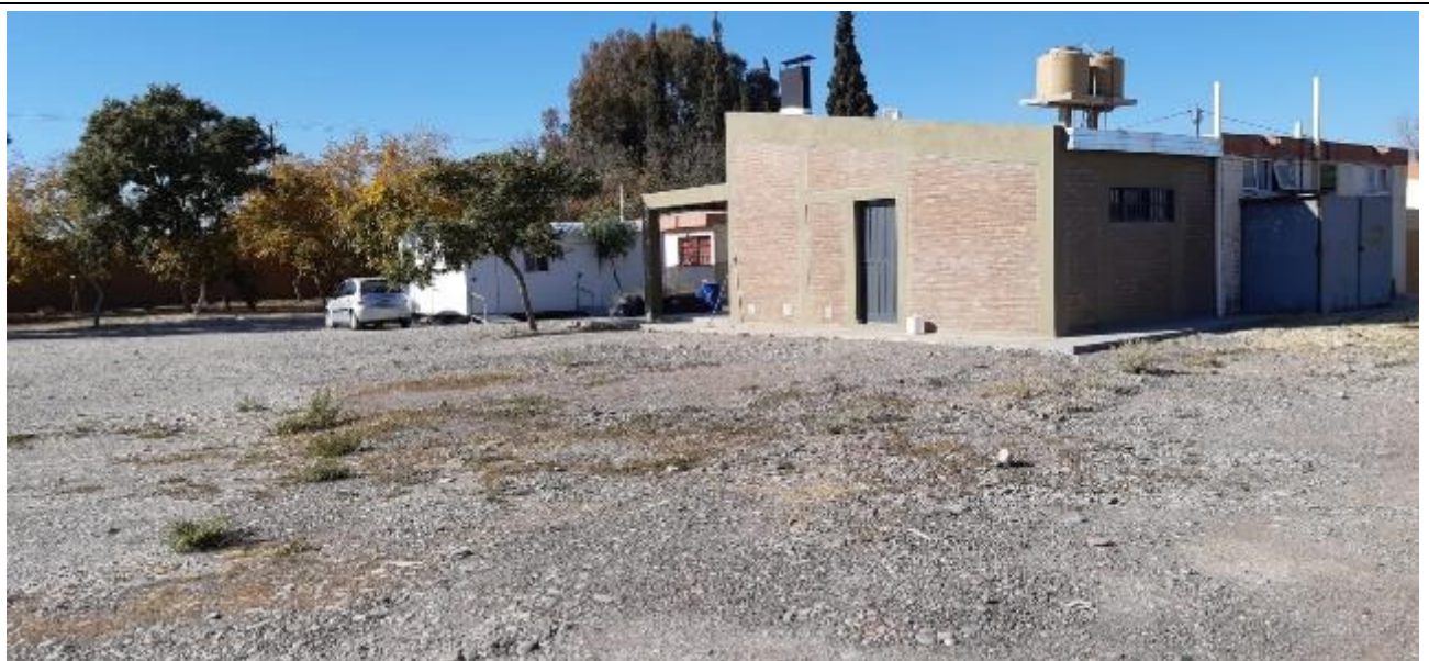
Fotografía N°2: Se muestra una imagen del frente del terreno estudiado, correspondiente al Nivel de Educación Inicial de la escuela Werfield Salinas.
