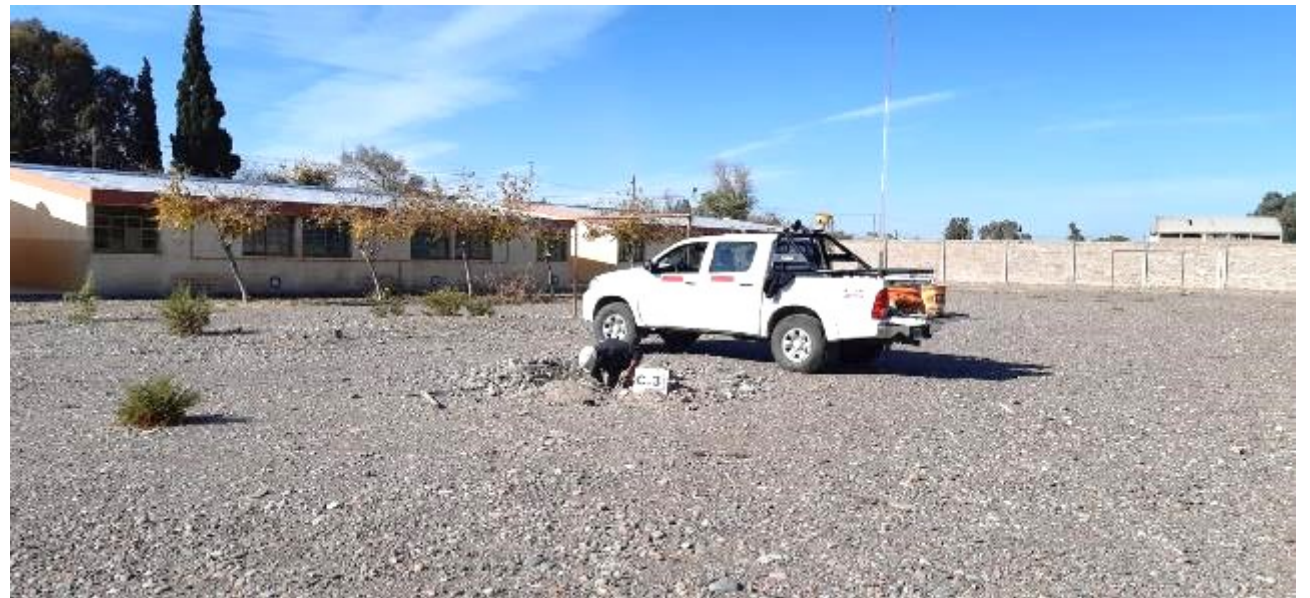
Fotografía N°16: Calicata C.3 . Se muestra la posición de la calicata ejecutada en el terreno estudiado, se observan los trabajos de excavación y toma de muestra.
