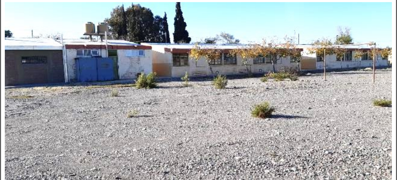
Fotografía N°3: Se muestra una imagen del frente del terreno estudiado, correspondiente al Nivel de Educación Inicial de la escuela Werfield Salinas.
