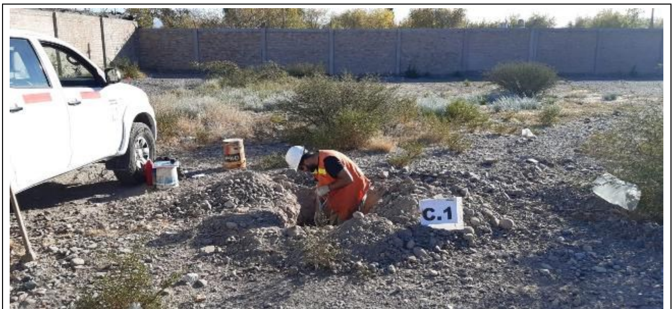
Fotografía N°8: Calicata C.1 . Se muestra la posición de la calicata ejecutada en el terreno estudiado, se observan los trabajos de excavación y toma de muestra.
