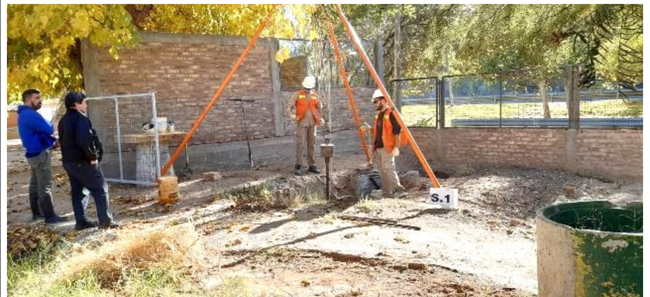
Fotografía N°9: Vista de la posición en el terreno del Sondeo S.1. Se observan los trabajos de perforación y toma de muestra, como así también el ensayo de penetración estándar (SPT).
