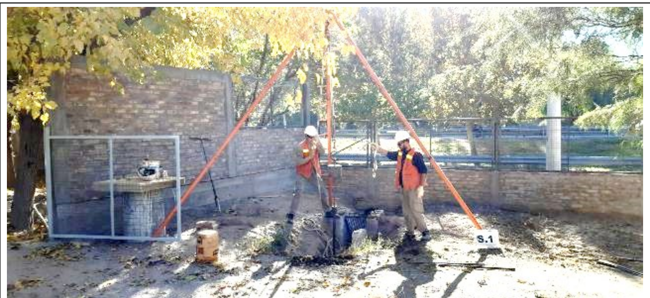
Fotografía N°10: Vista de la posición en el terreno del Sondeo S.1. Se observan los trabajos de perforación y toma de muestra, como así también el ensayo de penetración estándar (SPT).
