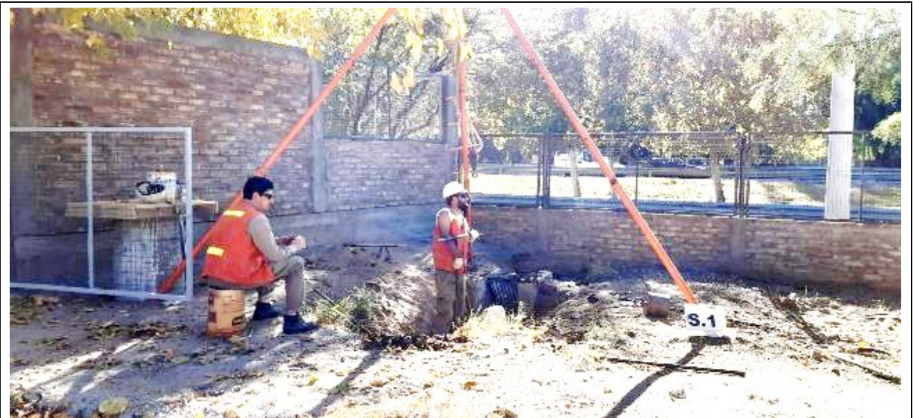
Fotografía N°8: Vista de la posición en el terreno del Sondeo S.1 . Se observan los trabajos de perforación y toma de muestra, como así también el ensayo de penetración estándar (SPT).
