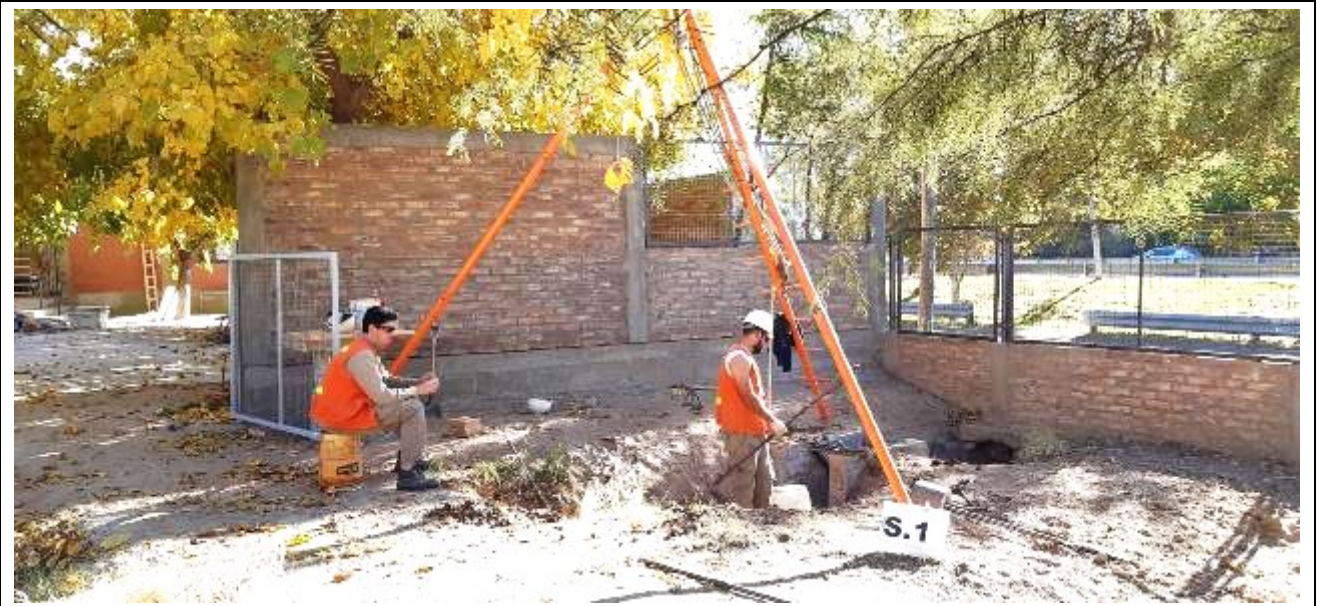
Fotografía N°7: Vista de la posición en el terreno del Sondeo S.1 . Se observan los trabajos de perforación y toma de muestra, como así también el ensayo de penetración estándar (SPT).
