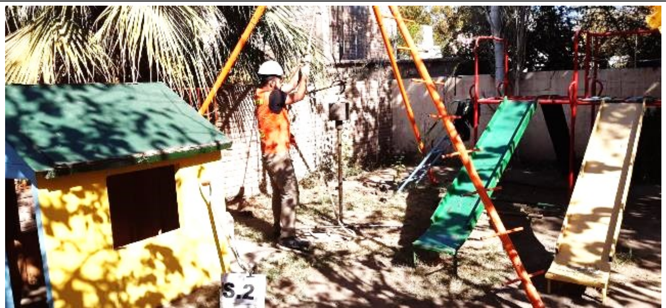
Fotografía N°14: Vista de la posición en el terreno del Sondeo S.2. Se observan los trabajos de perforación y toma de muestra, como así también el ensayo de penetración estándar (SPT).
