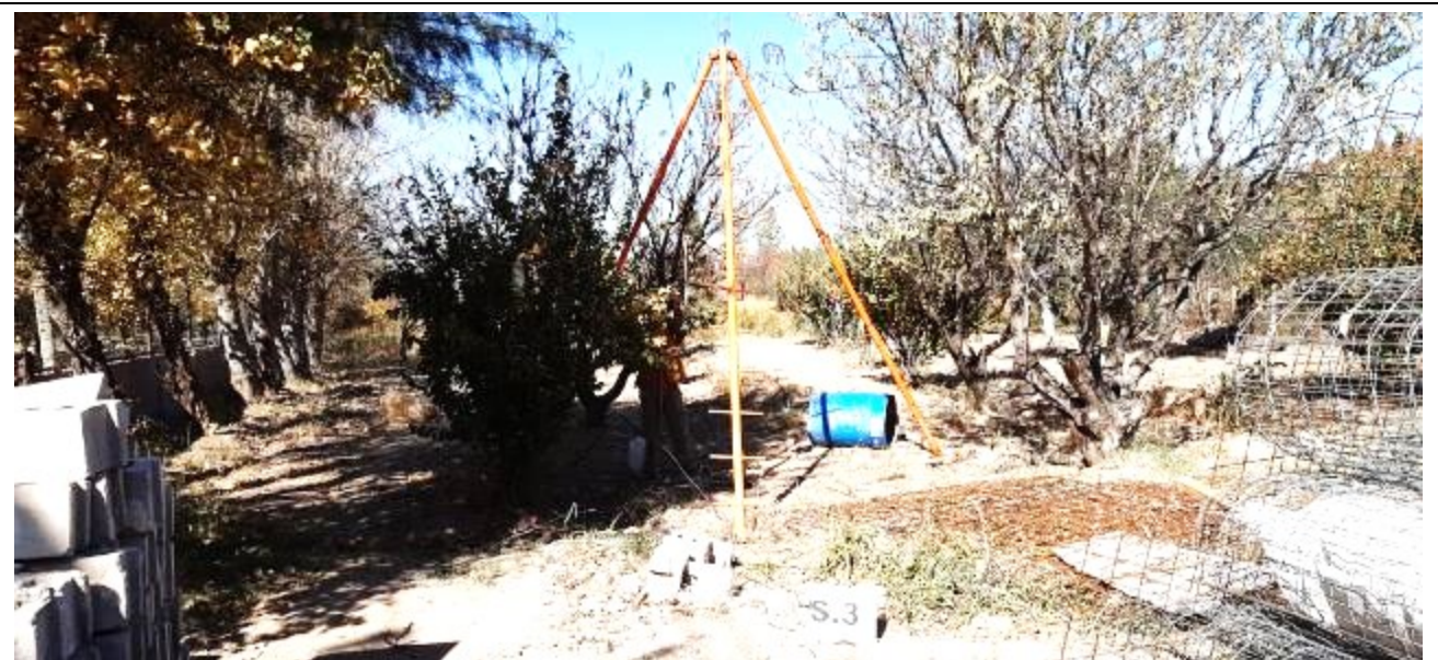
Fotografía N°16: Vista de la posición en el terreno del Sondeo S.3. Se observan los trabajos de perforación y toma de muestra, como así también el ensayo de penetración estándar (SPT).
