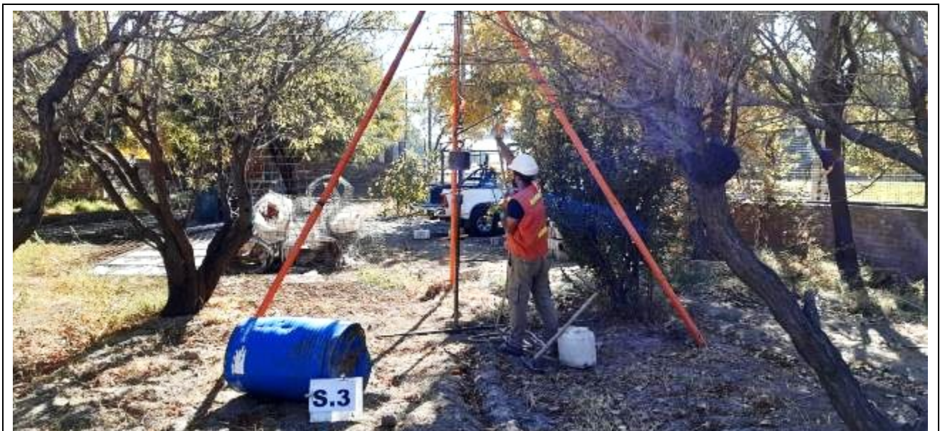
Fotografía N°18: Vista de la posición en el terreno del Sondeo S.3. Se observan los trabajos de perforación y toma de muestra, como así también el ensayo de penetración estándar (SPT).
