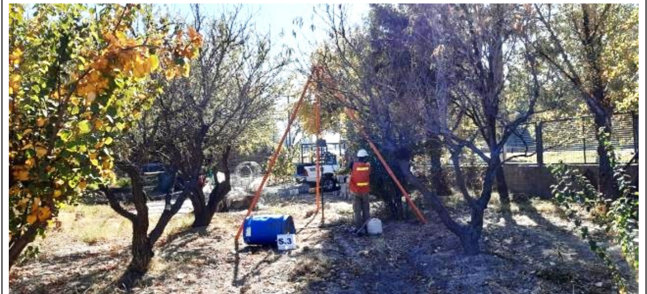
Fotografía N°17: Vista de la posición en el terreno del Sondeo S.3. Se observan los trabajos de perforación y toma de muestra, como así también el ensayo de penetración estándar (SPT).
