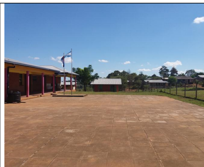
1- Vista patio existente 738
