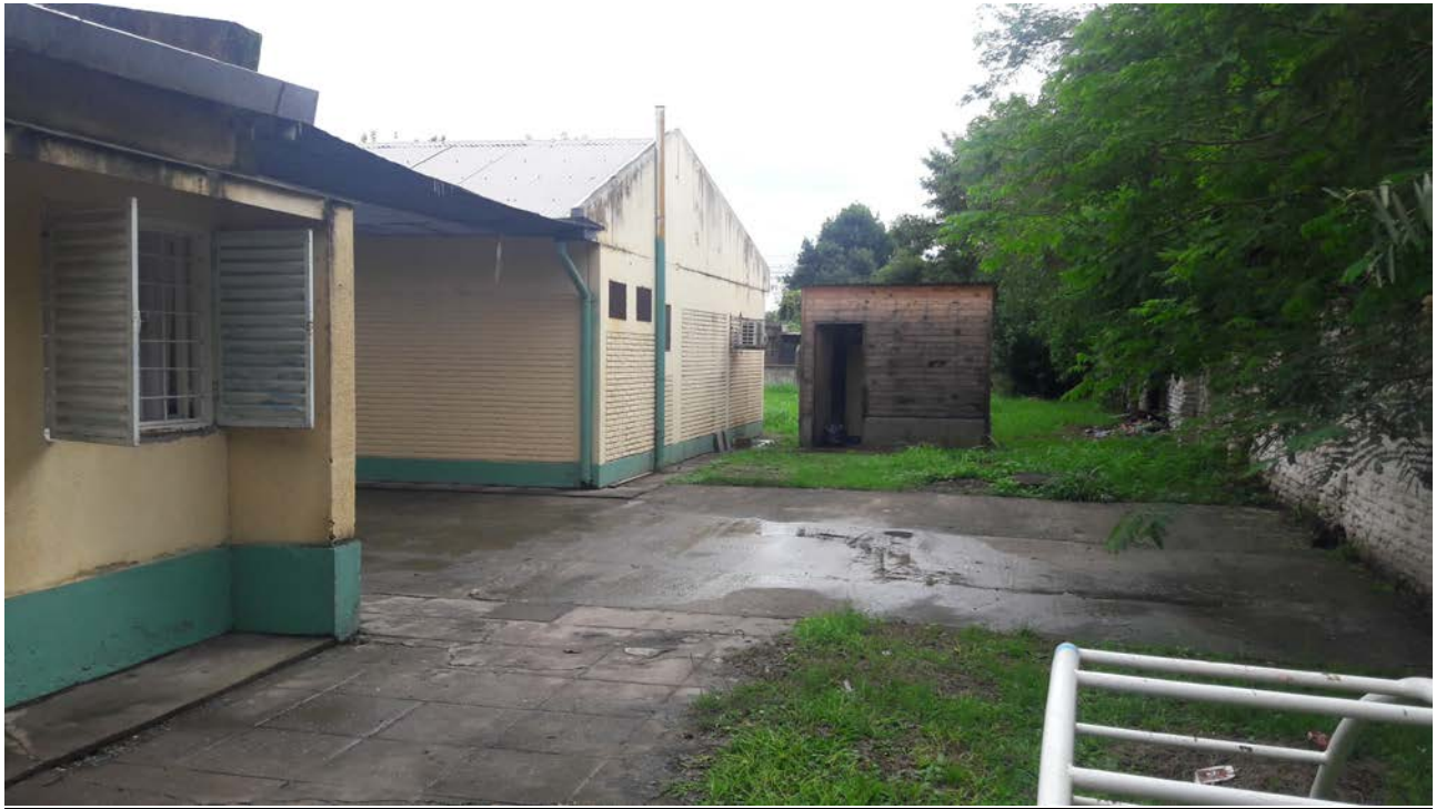
Vista de la casilla de madera a demoler
