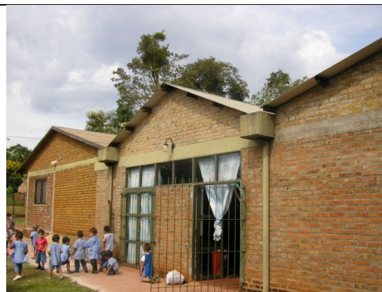
4- Vista lateral de edificio existente a refaccionar
