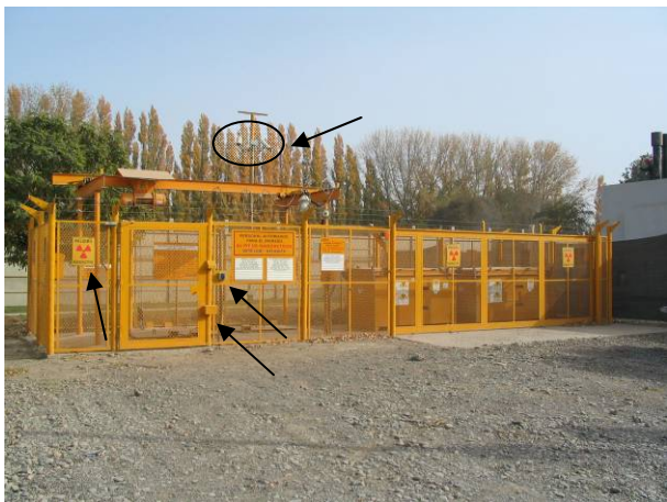
Figura 3. Señalización del depósito, sistemas de cámaras de televisión, sistema codificado de acceso al depósito. (Neuquén, Argentina)
