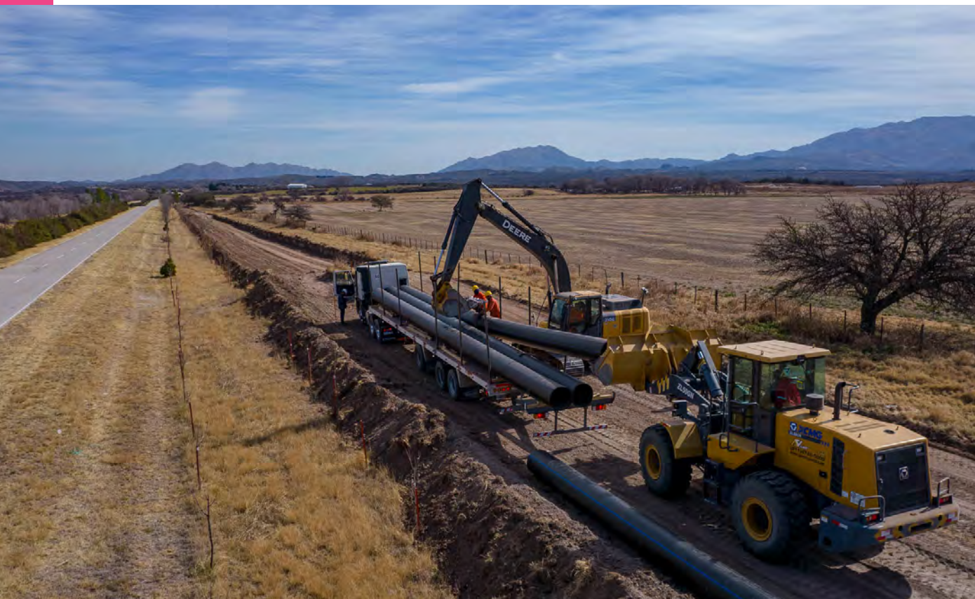
Nuevo acueducto La Florida II - Provincia de San Luis.
