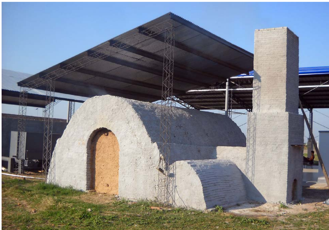
Proyecto BID Ladrilleros - Horno tiro invertido
