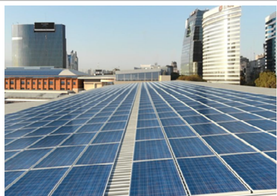
Instalación Solar Fotovoltaica-Ciudad Autónoma de Buenos Aires.
