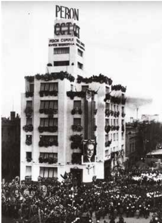
Funeral de Evita frente al edificio de la Confederación General del Trabajo, julio de 1952.
