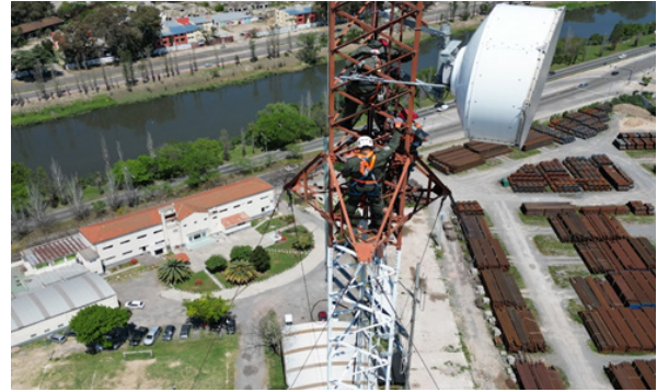
Registro fílmico con VANT- DRON del ascenso del personal de Subalfereces a la Torre de comunicaciones.
