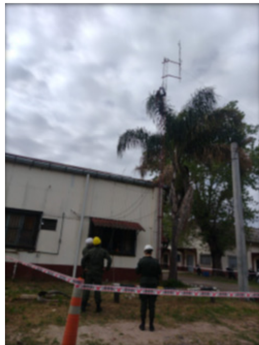
Reemplazo de antena Colineal.
