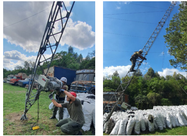
Instalación de malacate para posterior descenso de antena.
