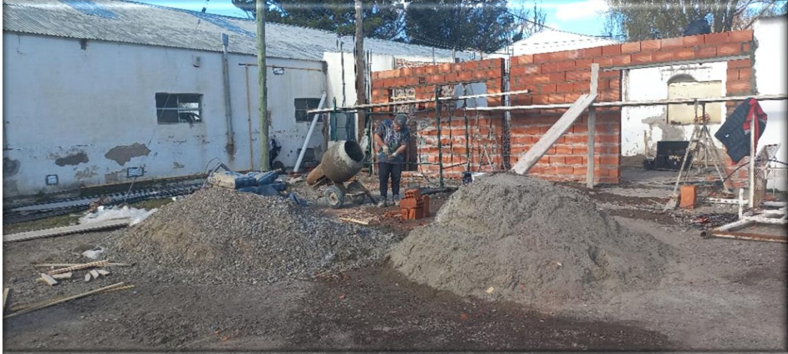
Inicio de obra
