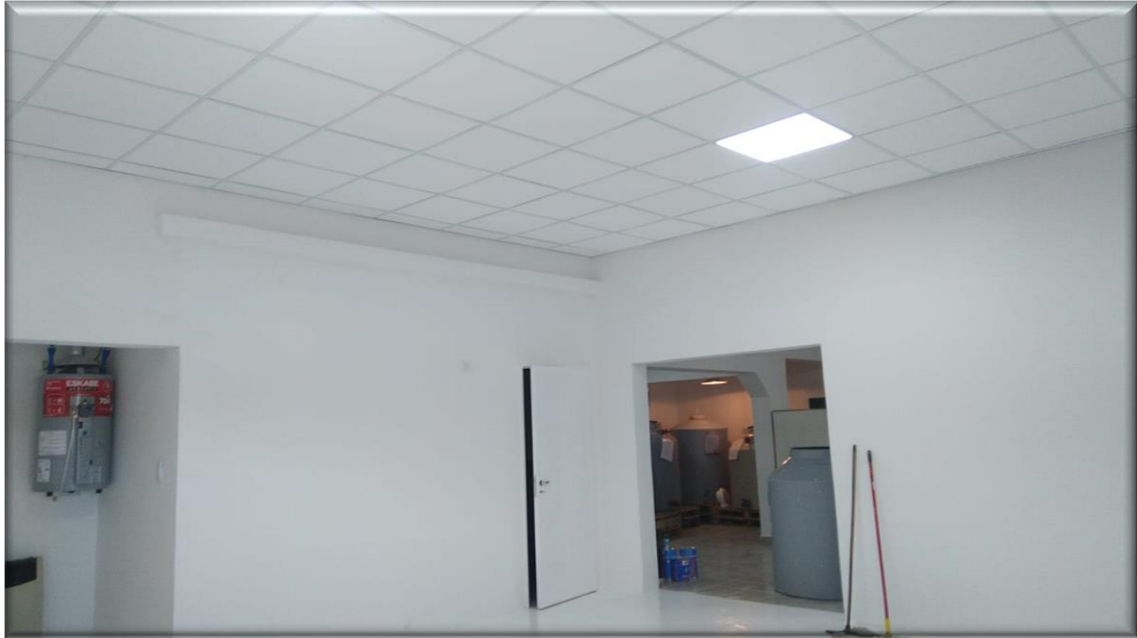
Interior y comunicación con espacio anterior
