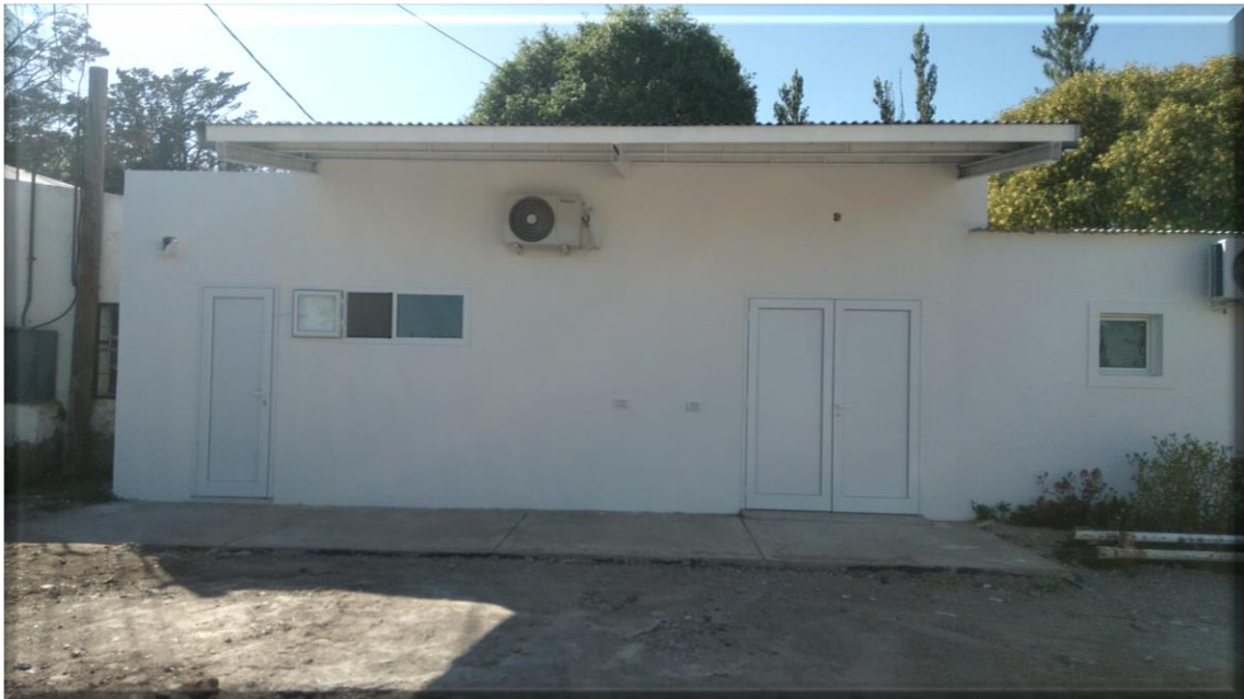
Frente de la sala de elaboración finalizada
