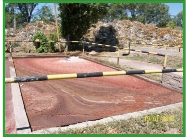
Foto 54: Pileta de Tratamiento
