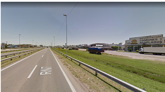
Vías de enlace - RN7 Junín, provincia de Buenos Aires.
