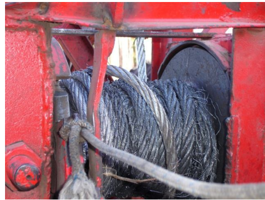
Foto N° 43 Cables de acero en mal estado
