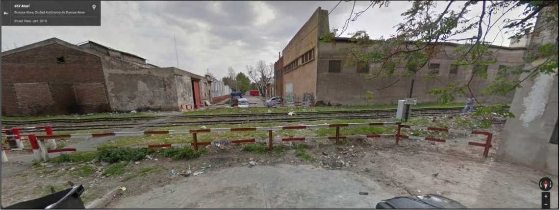
1-3 Vista hacia el norte de la calle Atuel
