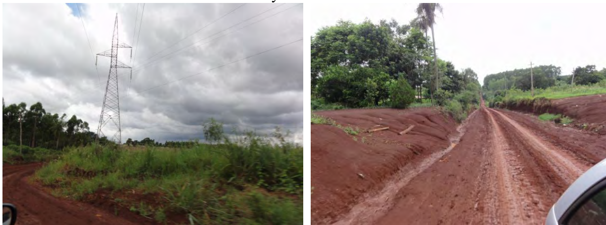
Foto 30. Camino de Acceso al Puerto Py
