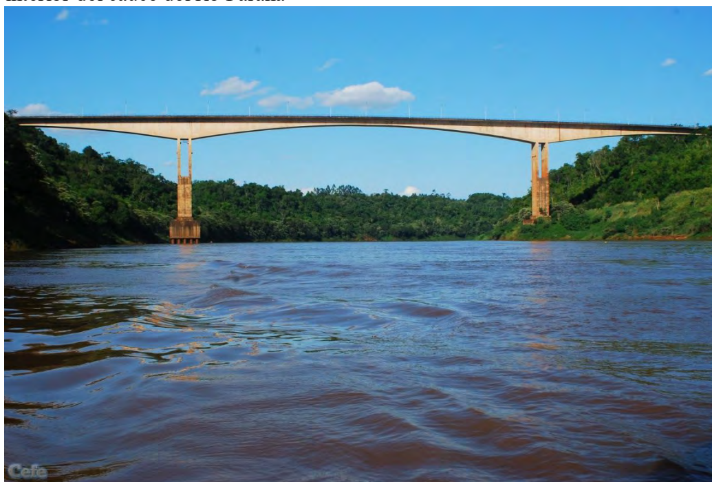
Foto 18. Puente Internacional Tancredo Neves, Puerto Iguazú y Foz de Iguazú, con pilas en el interior del cauce del río Paraná
