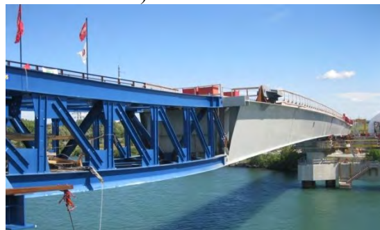
Foto 24. Puente de Beauharnois, de 82 m de luz principal y sección con cajón mixto, ejecutado mediante empuje, con nariz de lanzamiento (cercha de color azul).
