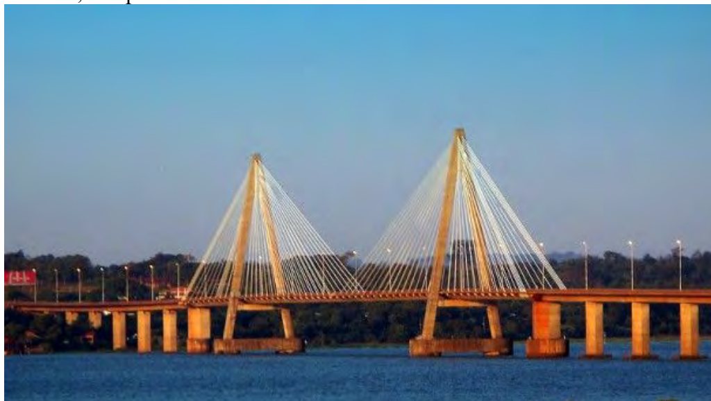
Foto 17. Puente Internacional San Roque González de Santa Cruz, entre Encarnación y Posadas, con pilas en el interior del cauce del río Paraná
