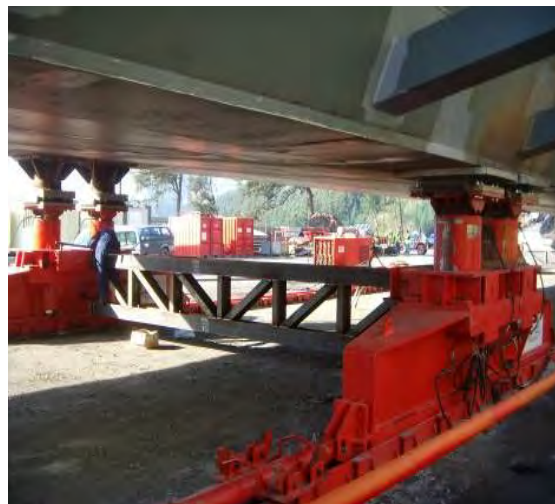
Foto 24. Puente de Beauharnois, de 82 m de luz principal y sección con cajón mixto, ejecutado mediante empuje, con nariz de lanzamiento (cercha de color azul).
