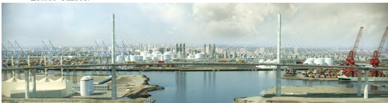
Foto 29. Puente Gerald Desmond, con 305 m de luz principal y 3600 m de longitud total, en Estado Unidos.
