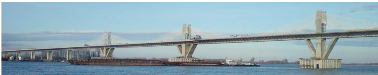
Foto 27. Puente de Vidin Calafat, con 180 m de luz principal y 1800 m de longitud total, en Rumanía.
