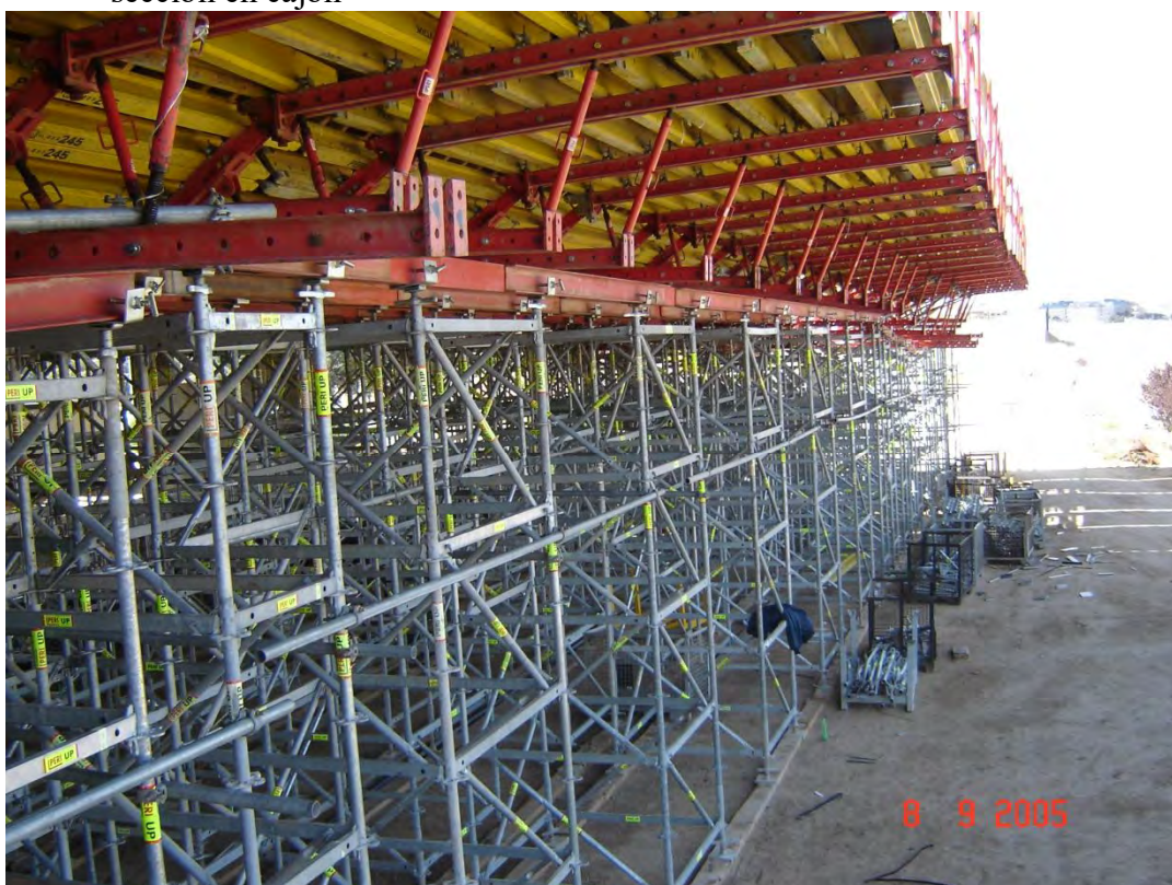
Foto 22. Ejemplo de cimbra cuajada cimentada en el terreno para la ejecución de tablero con sección en cajón
