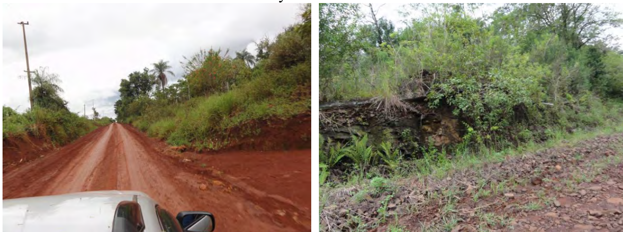
Foto 36. Camino de Acceso al Puerto Py
