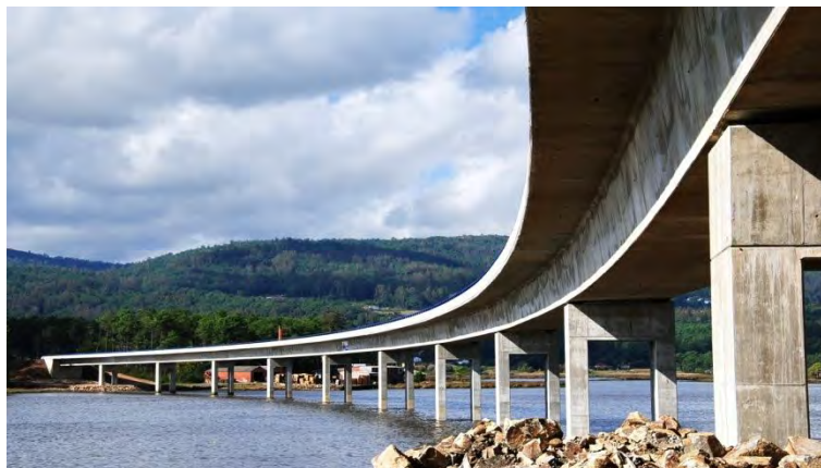
Foto 21. Puente de la bahía de Engano, en España, con cajón postesado ejecutado con cimbra autolanzable y luces de 70 m.
