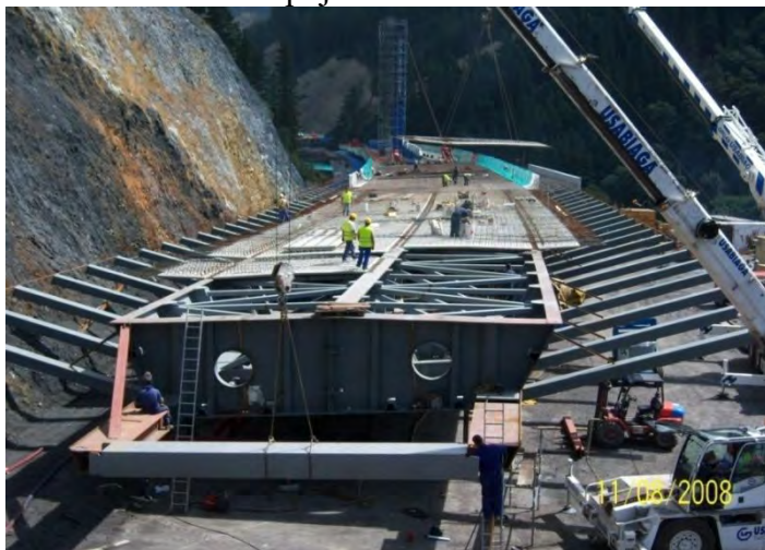
Foto 24. Puente de Beauharnois, de 82 m de luz principal y sección con cajón mixto, ejecutado mediante empuje, con nariz de lanzamiento (cercha de color azul).
