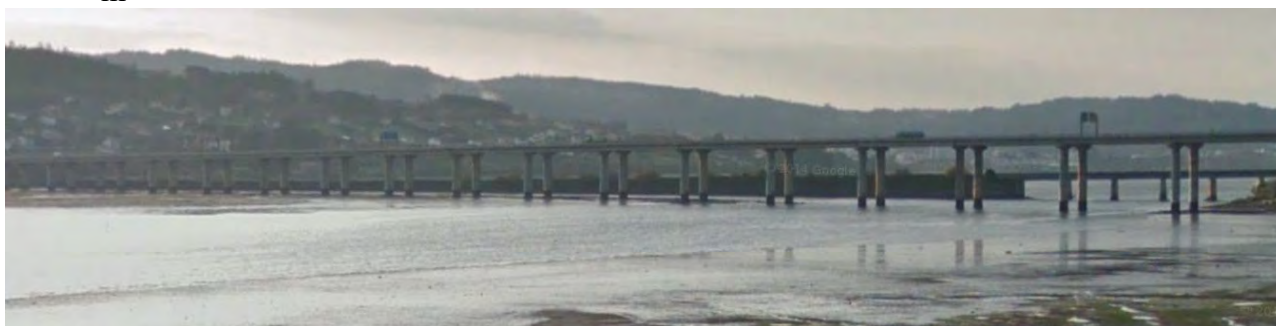
Foto 20. Alzado del puente de Ferrol, en España, con vigas artesas prefabricadas y luces de 45 m
