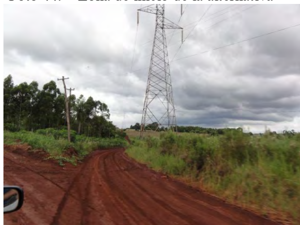
Foto 44. Zona de inicio de la alternativa
