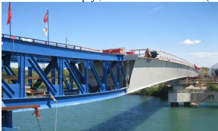
Foto 24. Puente de Beauharnois, de 82 m de luz principal y sección con cajón mixto, ejecutado mediante empuje, con nariz de lanzamiento (cercha de color azul).
