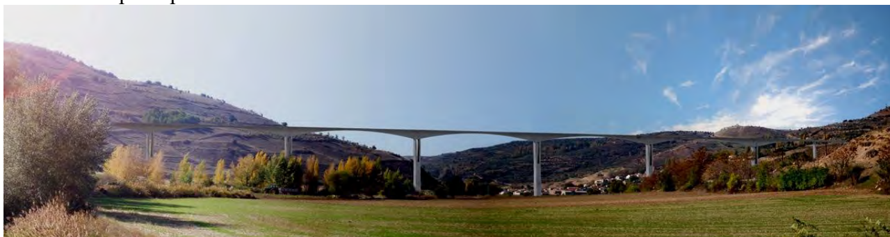
Foto 26. Alzado del puente sobre el río Tajuña, en España, con una luz máxima de 250 m de vano principal.
