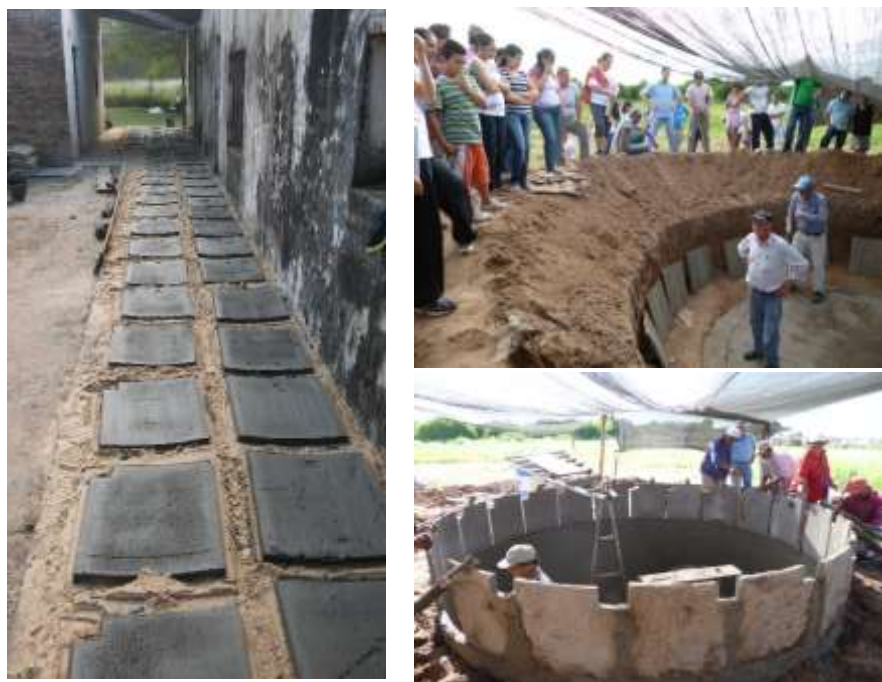
Ilustración 11. Construcción local de cisterna de placas.
