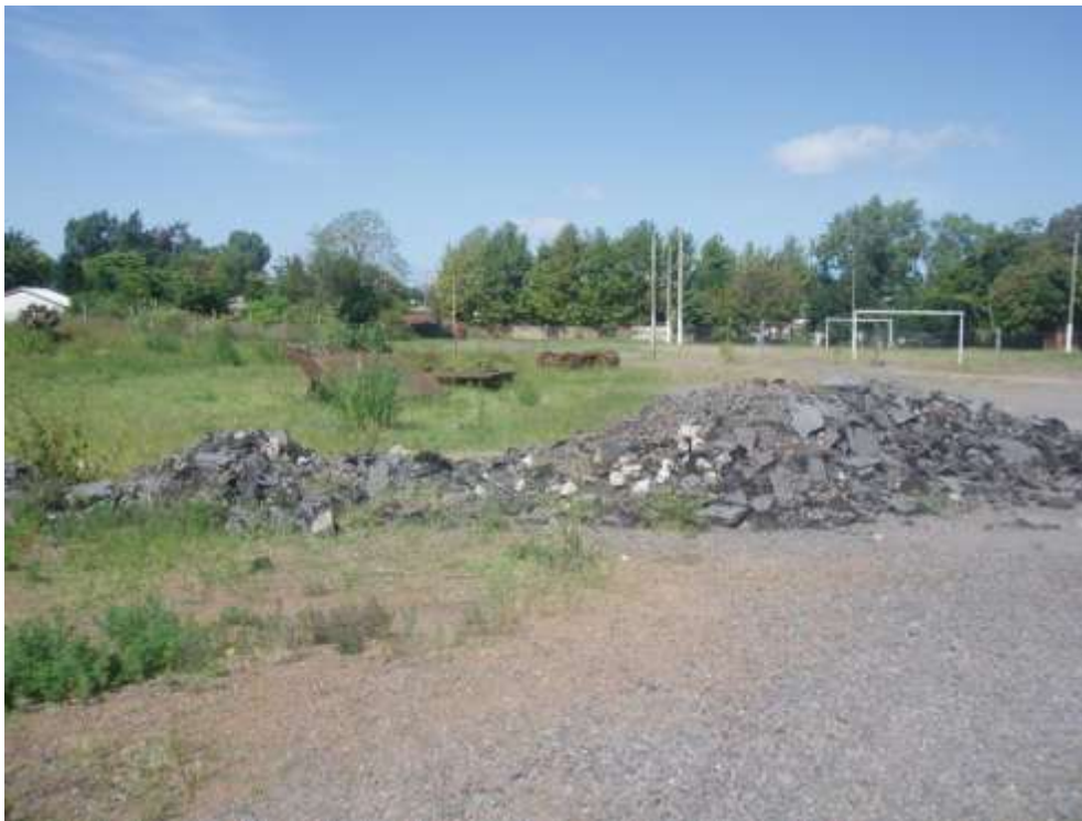
Foto 3-66. Escombros (restos de carpeta asfáltica).
