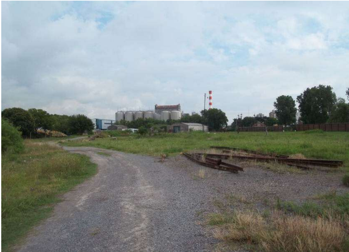
Foto 3-5. Camino interno (fuera de zona de implantación de la futura SET) e Instalaciones de la cervecería Quilmes al fondo de la Foto, vista al NO. Nótese materiales de deshecho ferroviario (rieles, durmientes, etc.).
