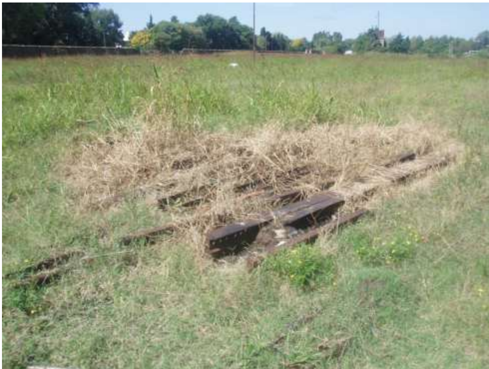
Foto.3-54. Tramos de vías en desuso.
