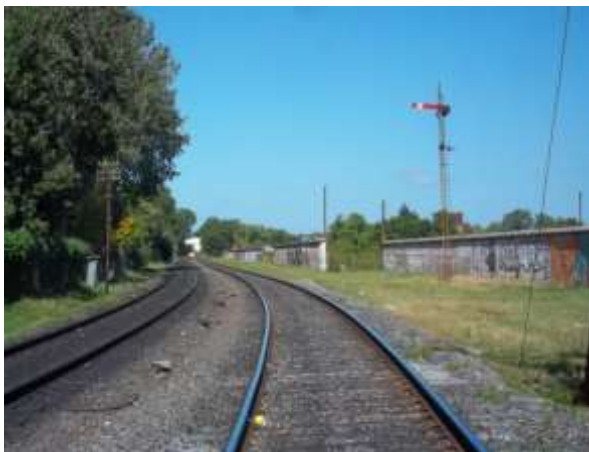
Foto 3-48. Vista al S las vías del ferrocarril al O se ubicará el SET.
