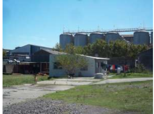
Foto 3-27. Vista NO, vivienda habitada dentro del predio.
