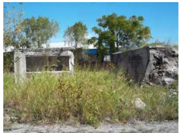
Foto 3-25. Vista al O, infr. del ferrocarril de cargas abandonada.
