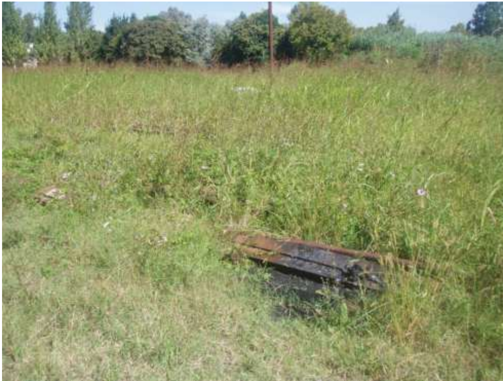
Foto 3-56. Tramos de vías en desuso.
