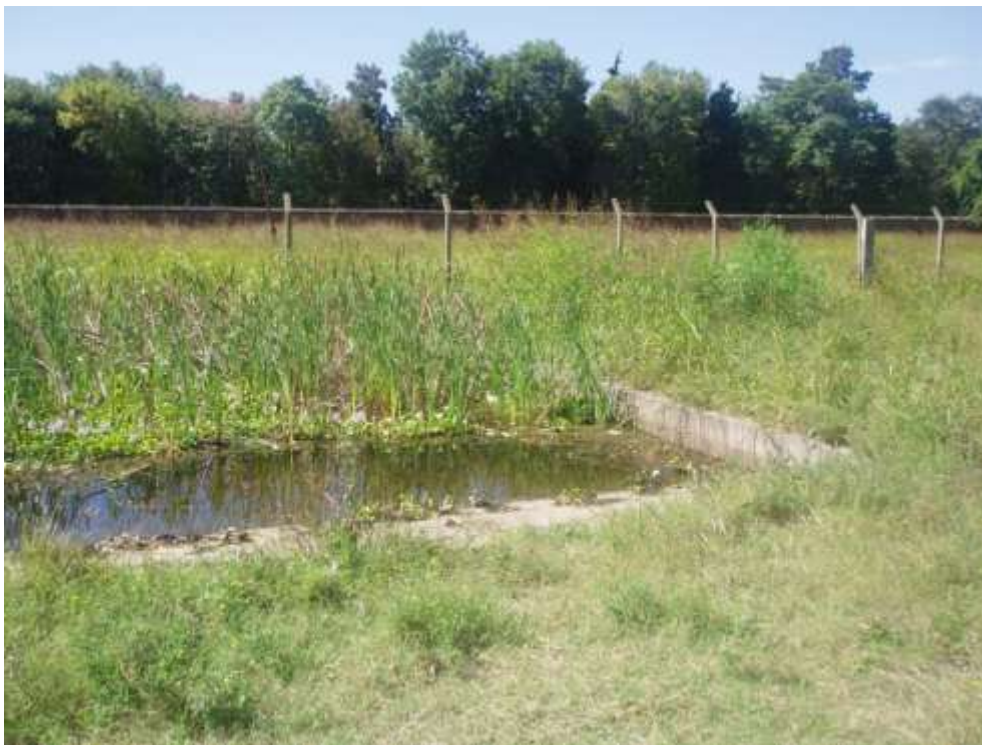
Foto 3-62. Pileta de cemento de características similares a la del pasivo 8. Se ubica el Este de la misma.
