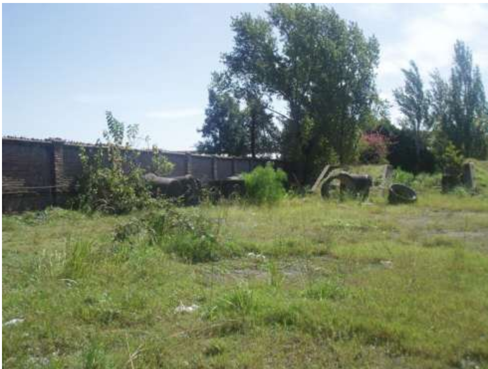
Foto 3-70. Tramos de cañería de hormigón en extremo O del predio.
