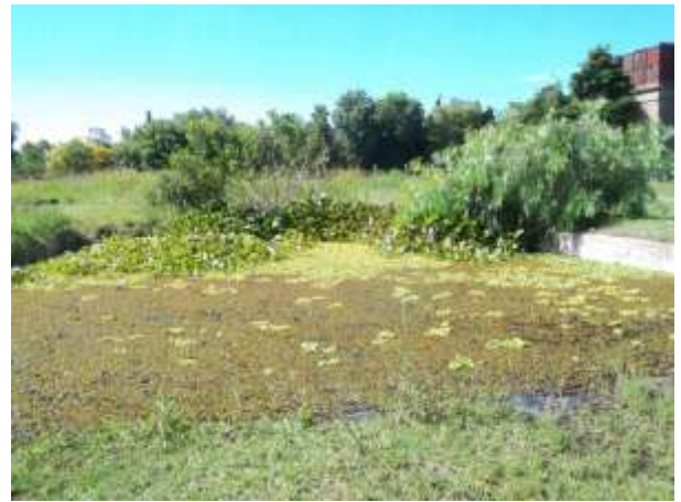
Foto 3-31. Vista al este, infr. del ferrocarril con agua estancada.
