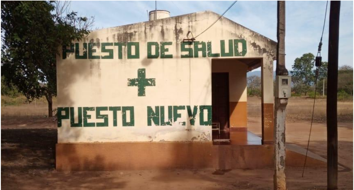
Foto 60. Puesto de Salud, Barrio Puesto Nuevo.
