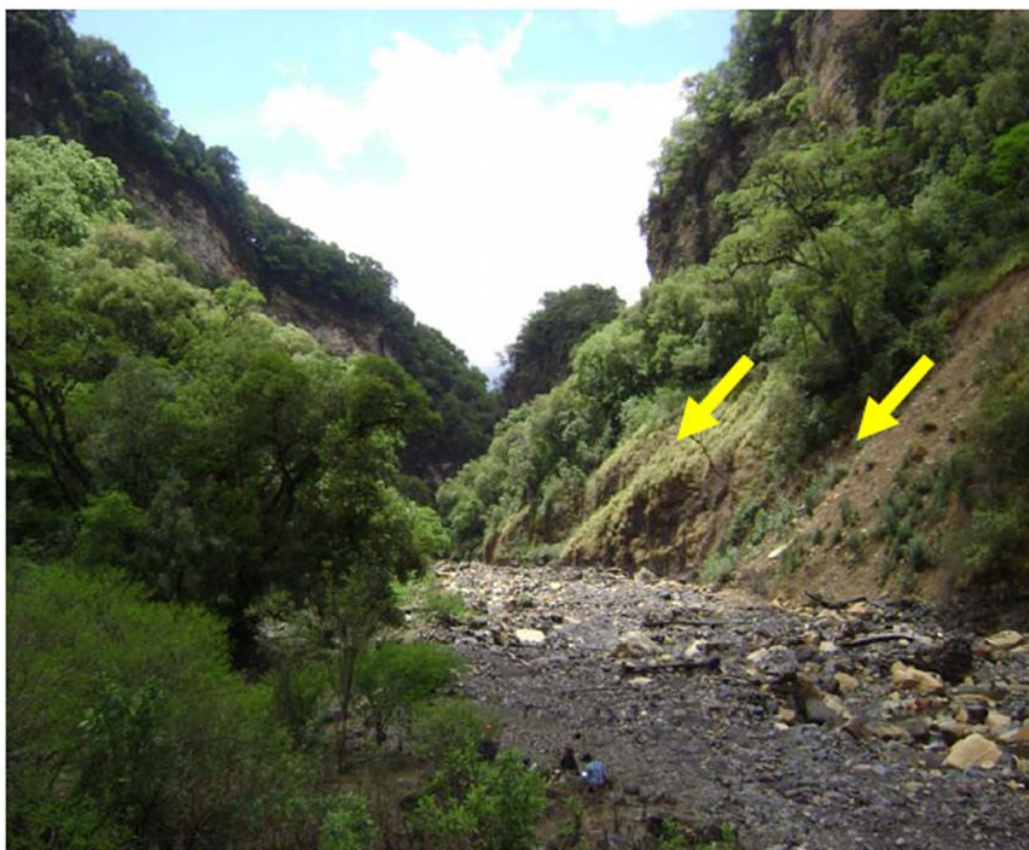
Foto 9: Deslizamientos sobre laderas del arroyo Santa Rita
