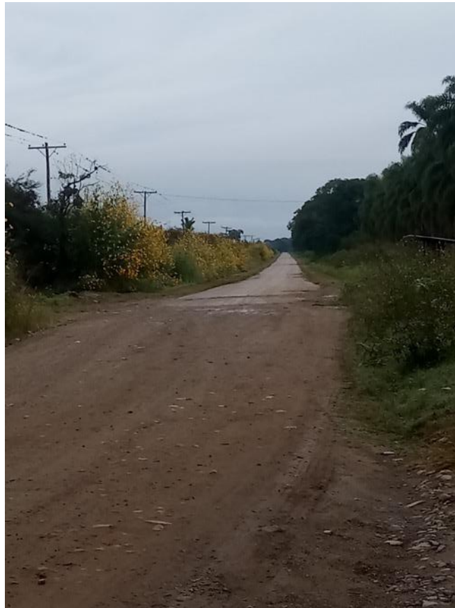
Foto 64. Transición de asfalto a tierra, Ruta Provincial N° 1, El Remate Chico.
