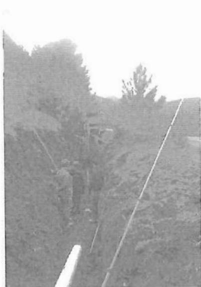
Ante la falta de provisión de cemento por parte del Municipio, se acuerda con el mismo realizar el tendido de cañería sin ejecución de cámaras.
