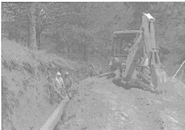
*Se realizó proyecto y ejecución de la 1° etapa del sistema de agua del Lote 27, contratados por el Municipio, se instalaron 500 metros de cañería de impulsión y se construyó una cisterna de H°A| de 200 m³.*
