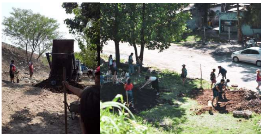
Trabajos de nivelación del terreno.
