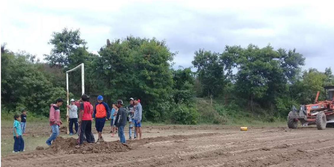
Figura 7 y 8. Nivelación del terreno y estudio de niveles
