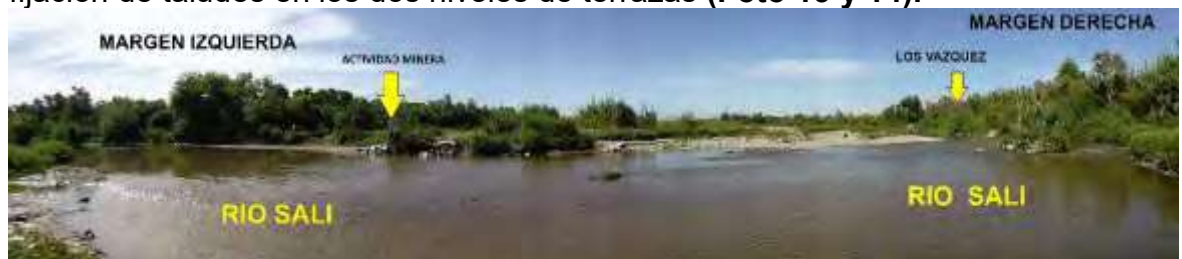
Foto 13: Vista al Sur del Río Salí mostrando ambas márgenes (con trabajos mineros= Extracción de áridos) en su margen izquierda).
