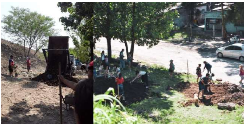
Trabajos de nivelación del terreno
