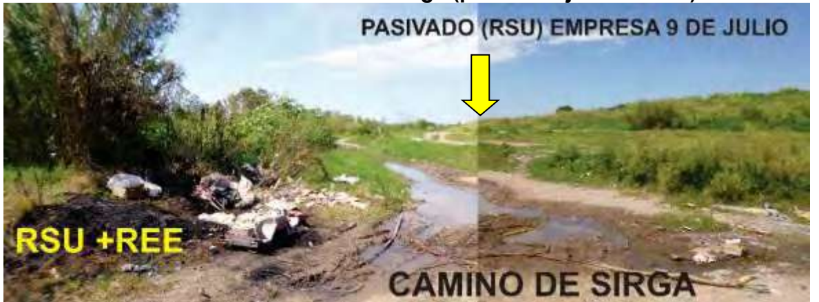
Foto 11: Vista al sur del camino de sirga que conduce al Ex Vertedero de la Empresa 9 de Julio (actualmente pasivado) y colonizado por vegetación.
