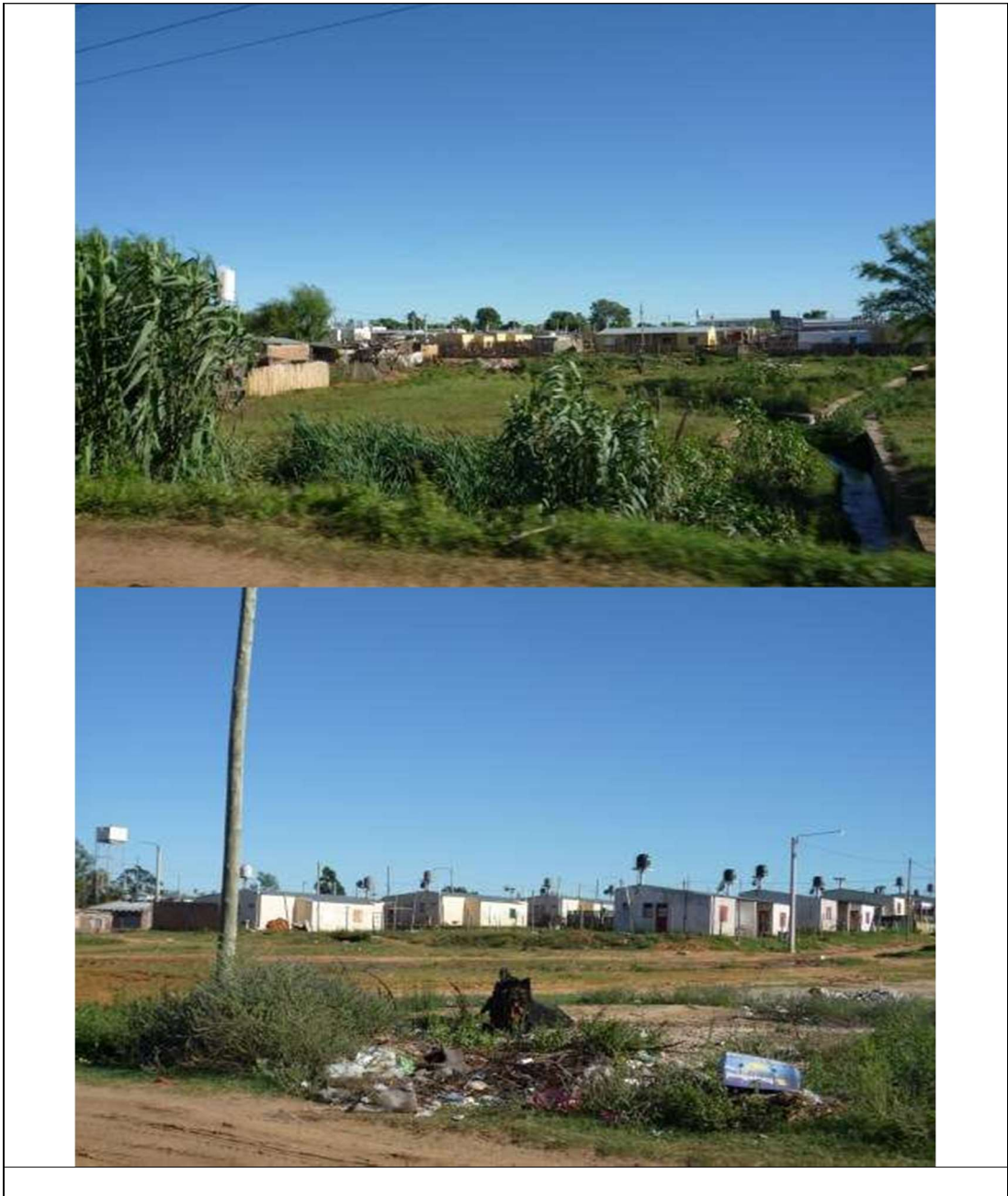
Predio Campo El Abasto: accesos, entorno e infraestructura en el sitio.
