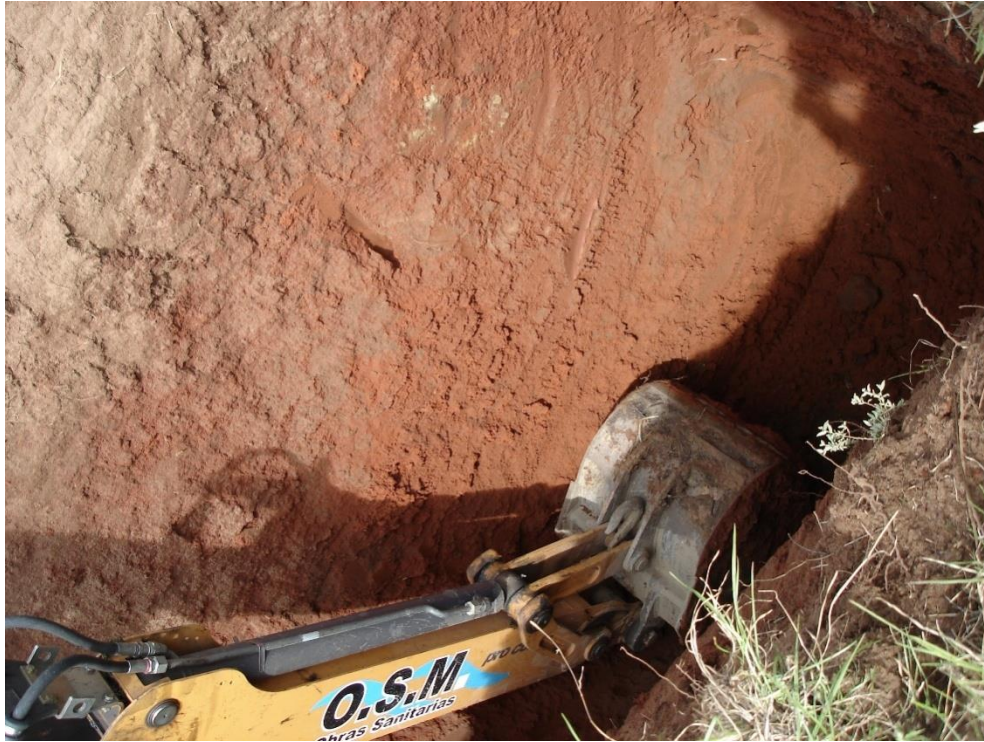
Figura 15. Excavación del pozo C4, donde a pocos centímetros de la superficie se halló agua de la napa freática
