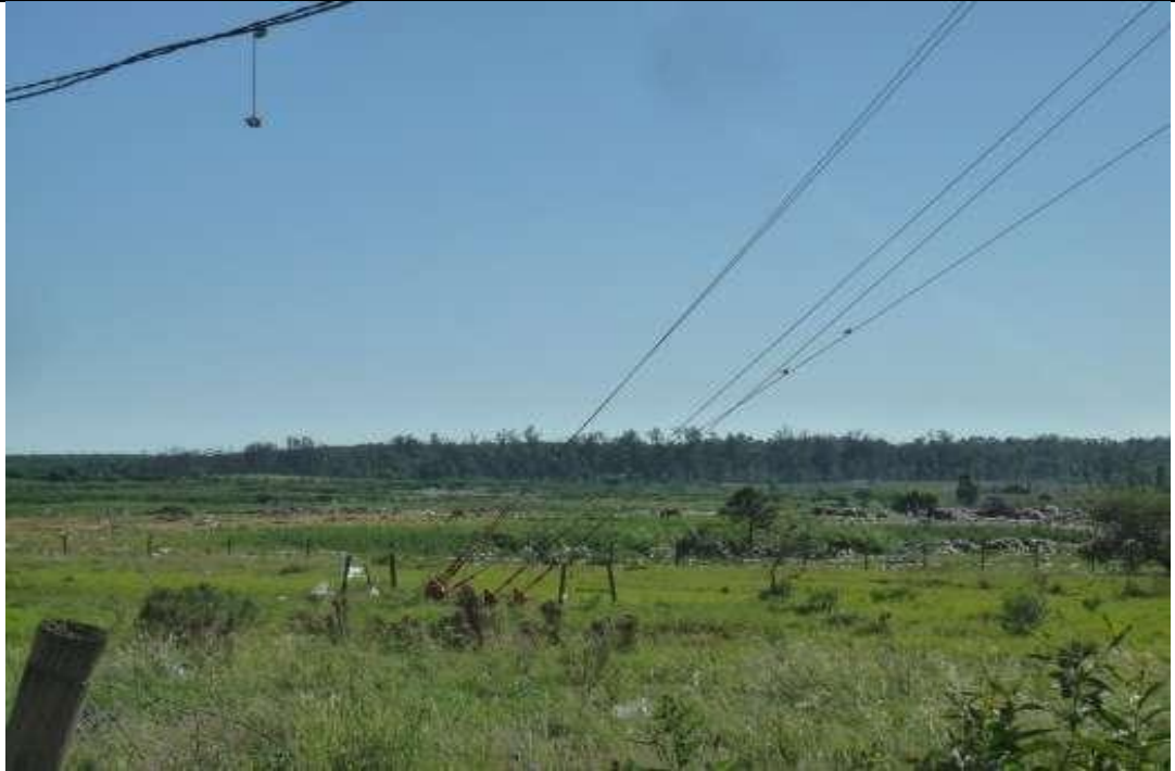
Vista del sector destinado al futuro relleno desde el camino de ingreso al predio.
