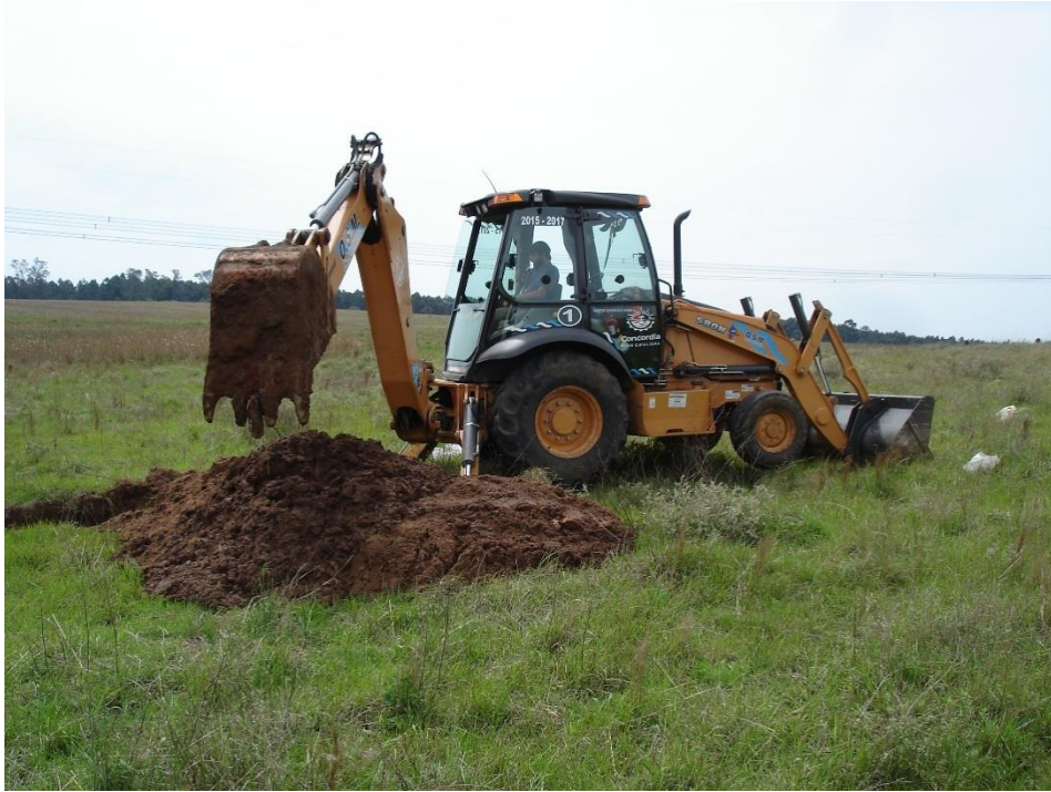
Figura 16. Herramienta retroexcavadora desarrollando el pozo C5 sobre el faldeo oeste del predio
