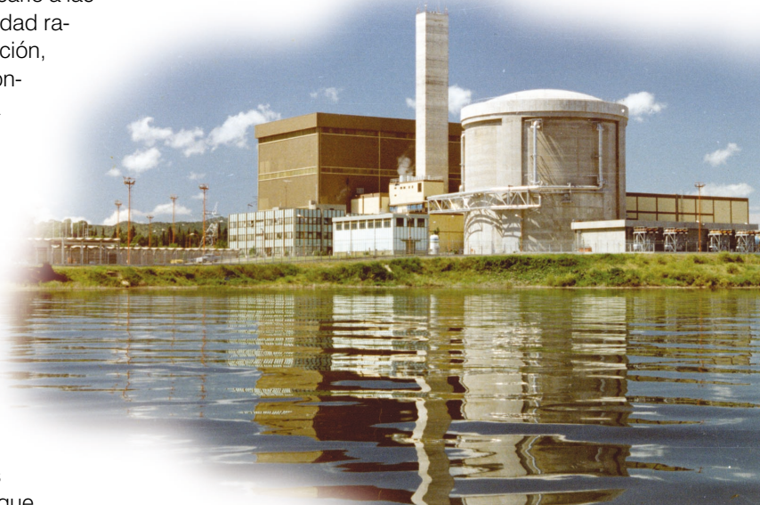
Vista panorámica de la Central Nuclear Embalse
