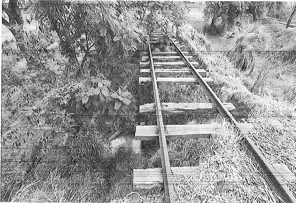
Fig. 12: Terraplén socavado.
