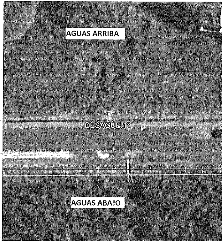
Fig. 2: Desagüe 1, dirección del agua.
