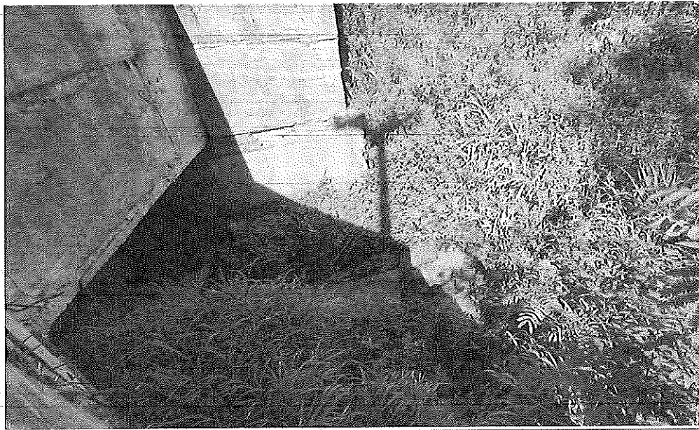
Fig. 7: Alcantarilla aguas arriba
