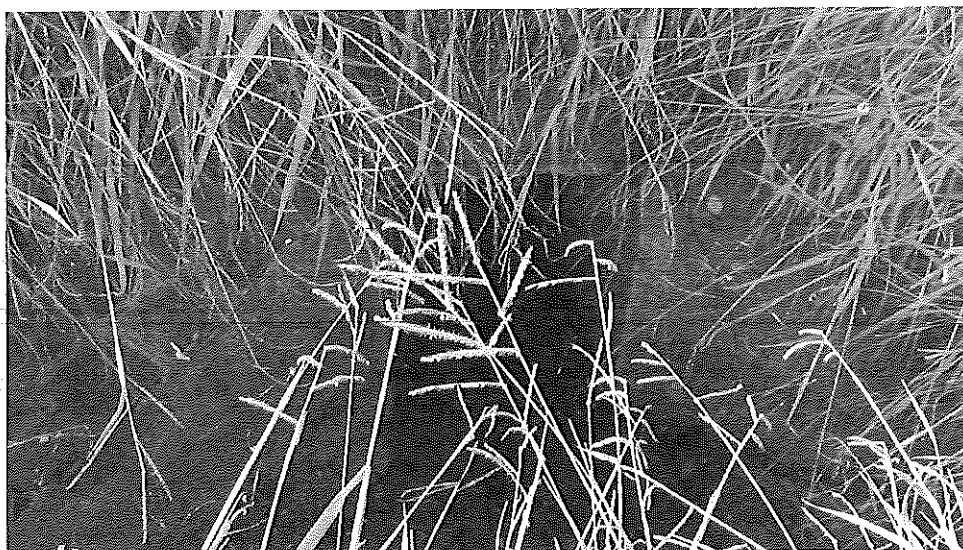
Fig. 11: Ingreso canal cerrado.
