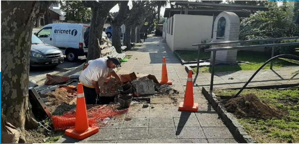
Cavado de fosa e instalación de caja de inspección fibra óptica tritubo AGP
