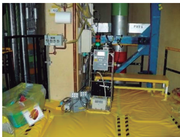
Preparación de la mini-zona en el área de generadores de vapor
