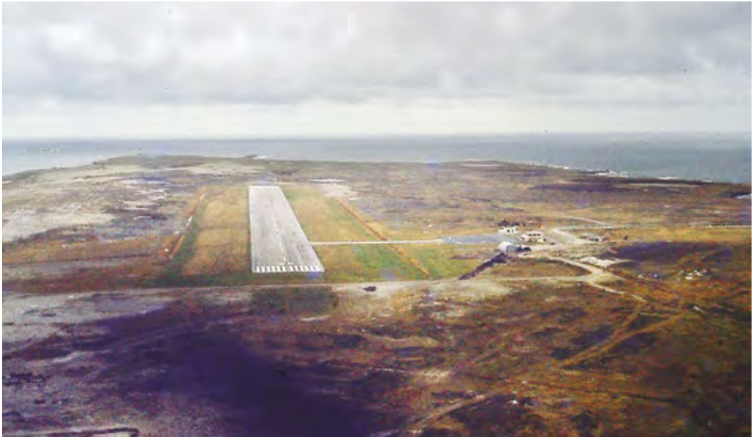
Pista del aeropuerto de Stanley finalizada - Gentileza: Com. (R) Canosa
