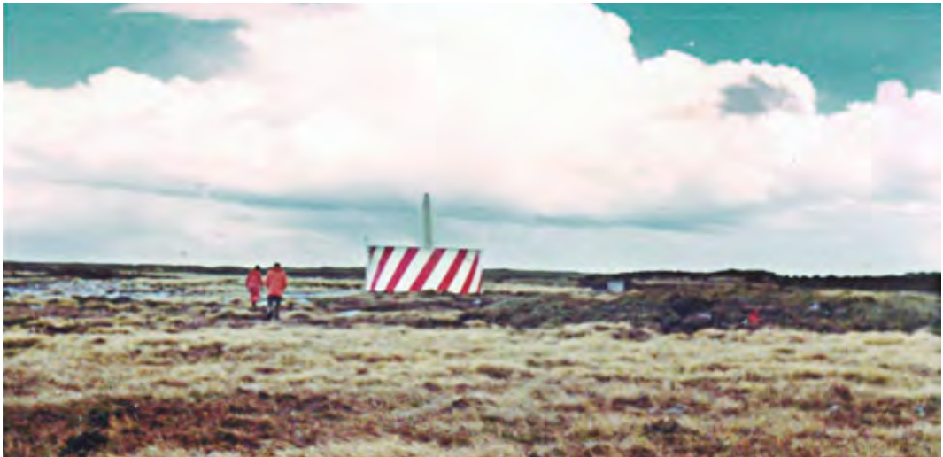
Radiofaro VOR instalado por la Fuerza Aérea Argentina en proximidades del aeropuerto de Puerto Stanley
