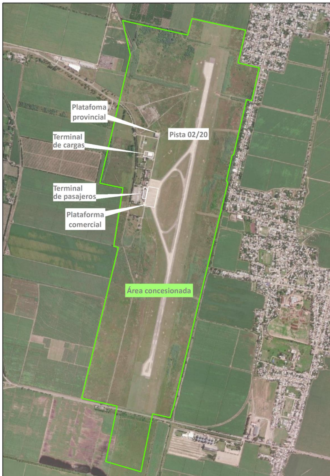
Imagen 1. Predio y área concesionada del Aeropuerto Internacional de Tucumán
